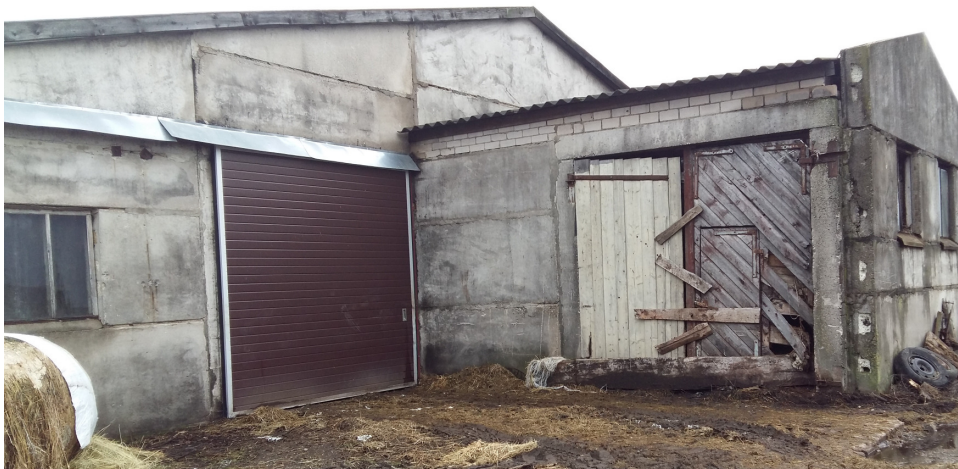
2. pav. Pastato vaizdas iš rytų pusės
