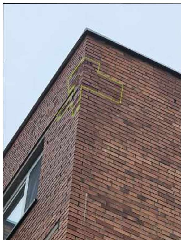
6 pav. Rytų fasadas
