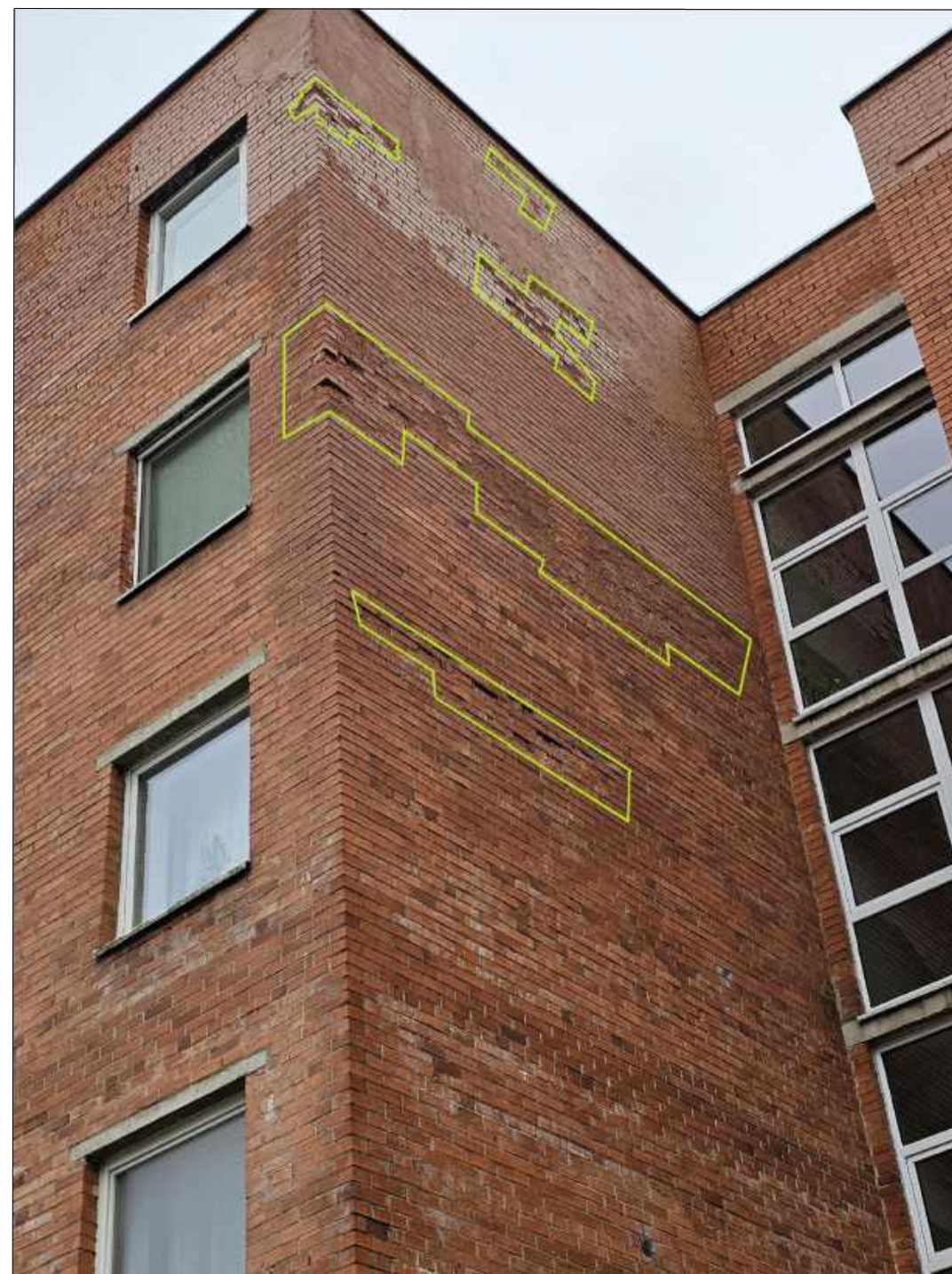
2 pav. Šiaurės fasadas
