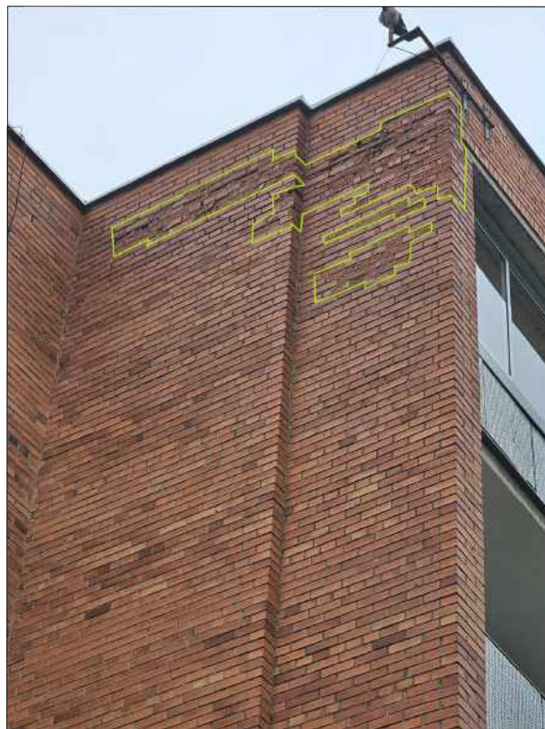
4 pav. Rytų fasadas
