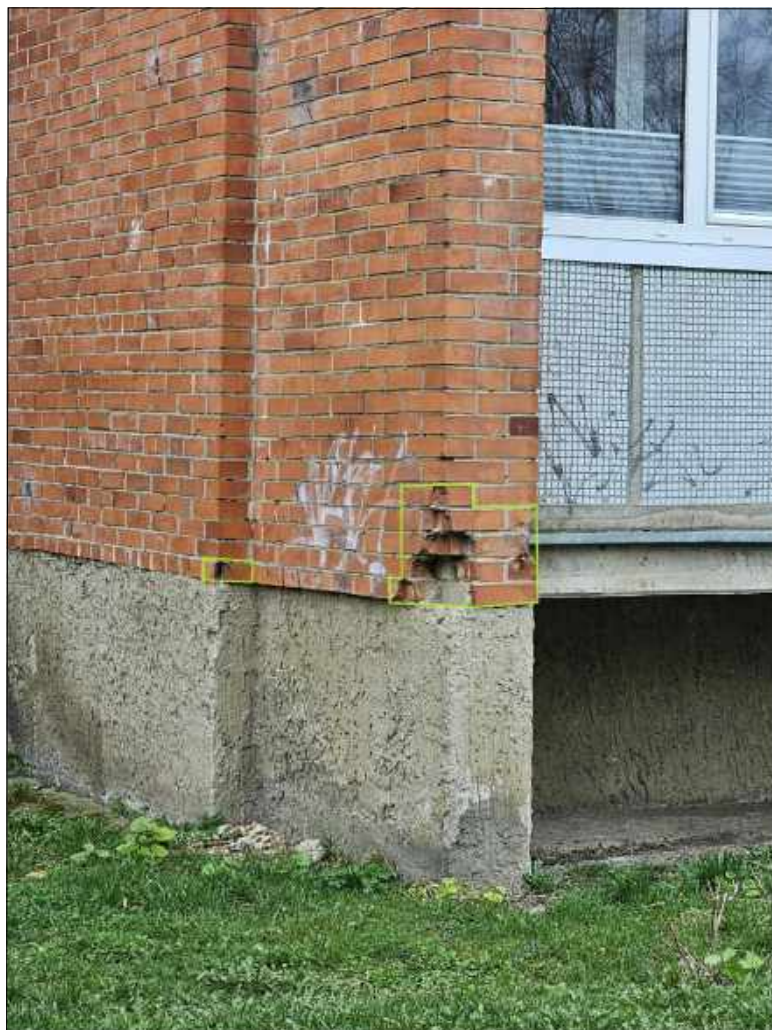
3 pav. Rytų fasadas
