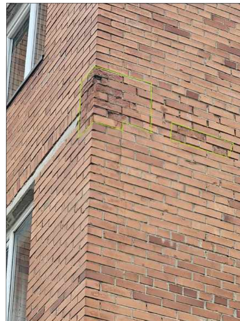
5 pav. Rytų fasadas
