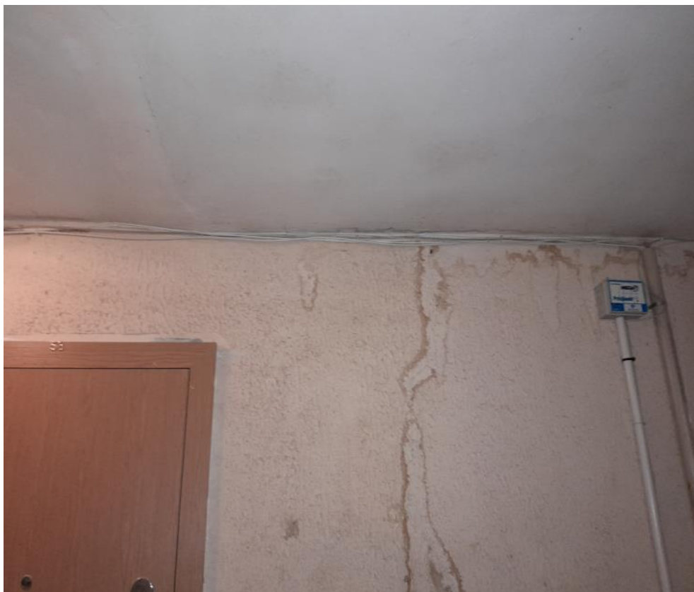
Vent. šachtos skardos keitimas 1,5 m 2
