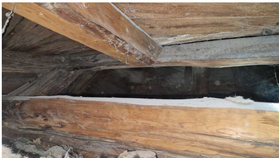
5 pav. Piramidės formos stogas: stogo plokštumos pakitimo plote yra matomų atvirų ertmių dangoje
