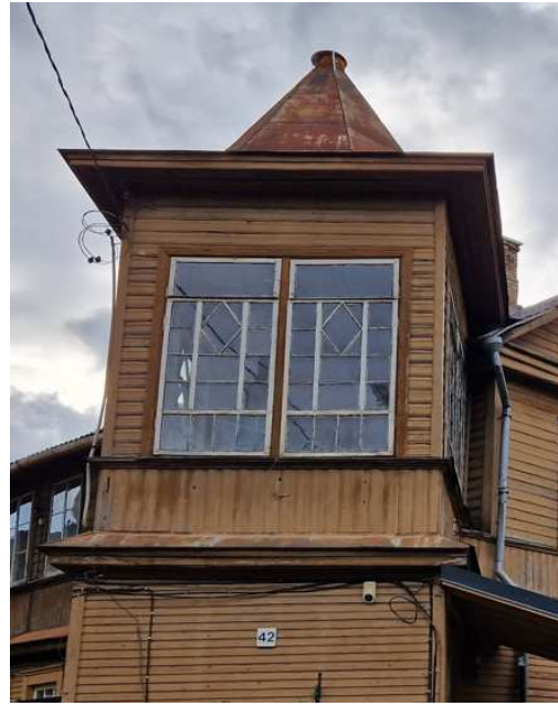
11 pav. po piramidės stogu (rizalito dalyje) karnizas neturi deformacijų ir netekčių
