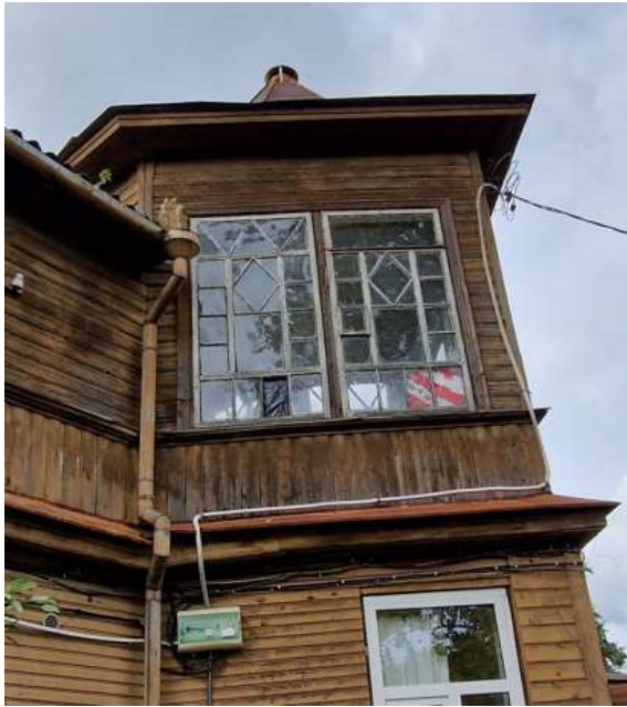
11 pav. po piramidės stogu (rizalito dalyje) karnizas neturi deformacijų ir netekčių
