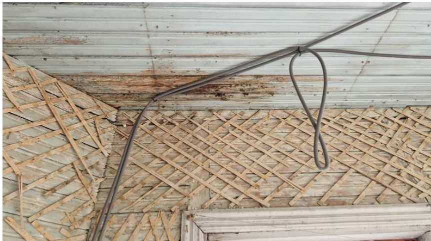
8 pav. Dar viena II a. lubų dalis, kai vanduo teka pro nesandarią stogo dangą
