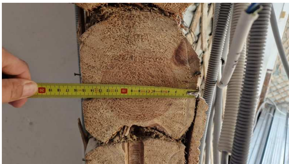
6 pav. Pastato reprezentuojantis laikancios sienos skerspjūvis
