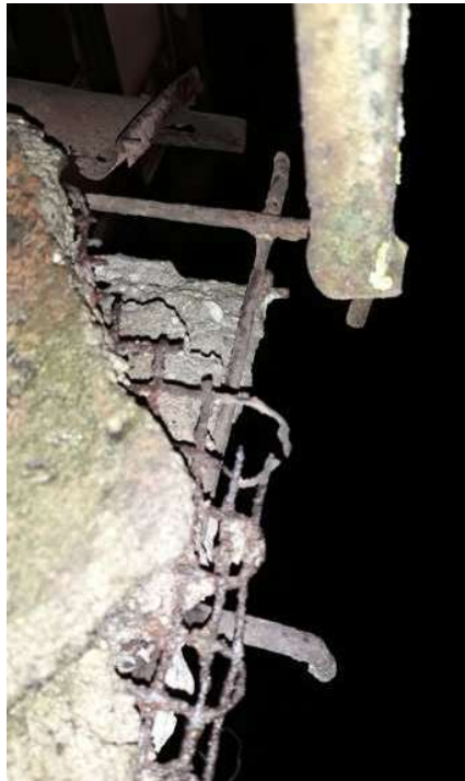
8 pav. Balkonuose tvorelės tvirtintos prie 20x3 mm plieno juostų, kurio ankeruotos į g/b plokštę.
