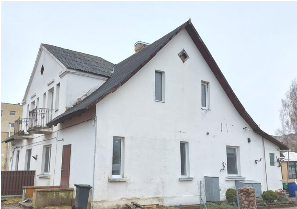
3.pav. pastato fotofiksacija iš vakarinės pusės.
