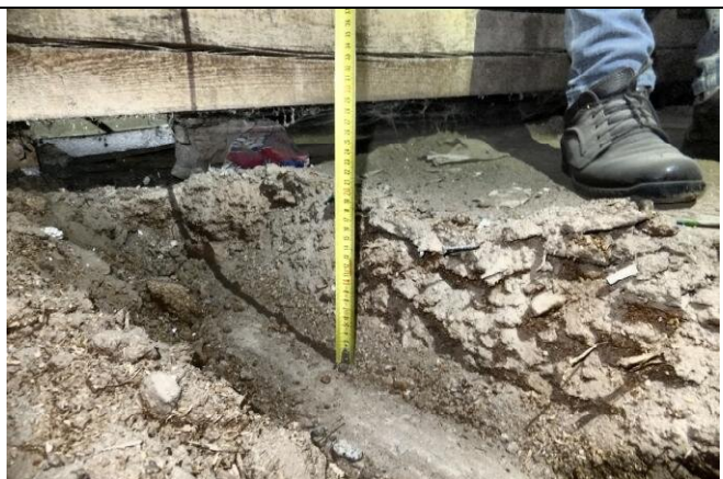
11 pav. Pamatuotas viršutinio perdangos sluoksnio storis.
