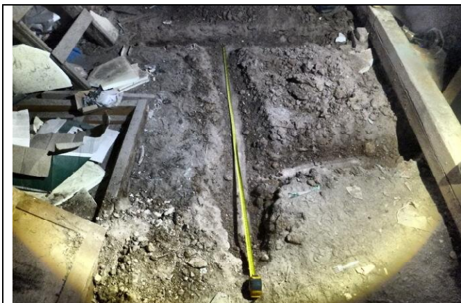
10 pav. Iškasti grioviai viršutiniame perdangos sluoksnyje.
