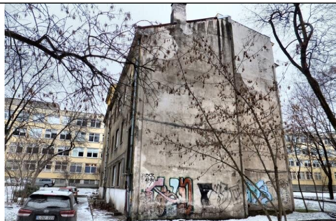
2 pav. Bendras tiriamo pastato vaizdas iš vakarų pusės.
