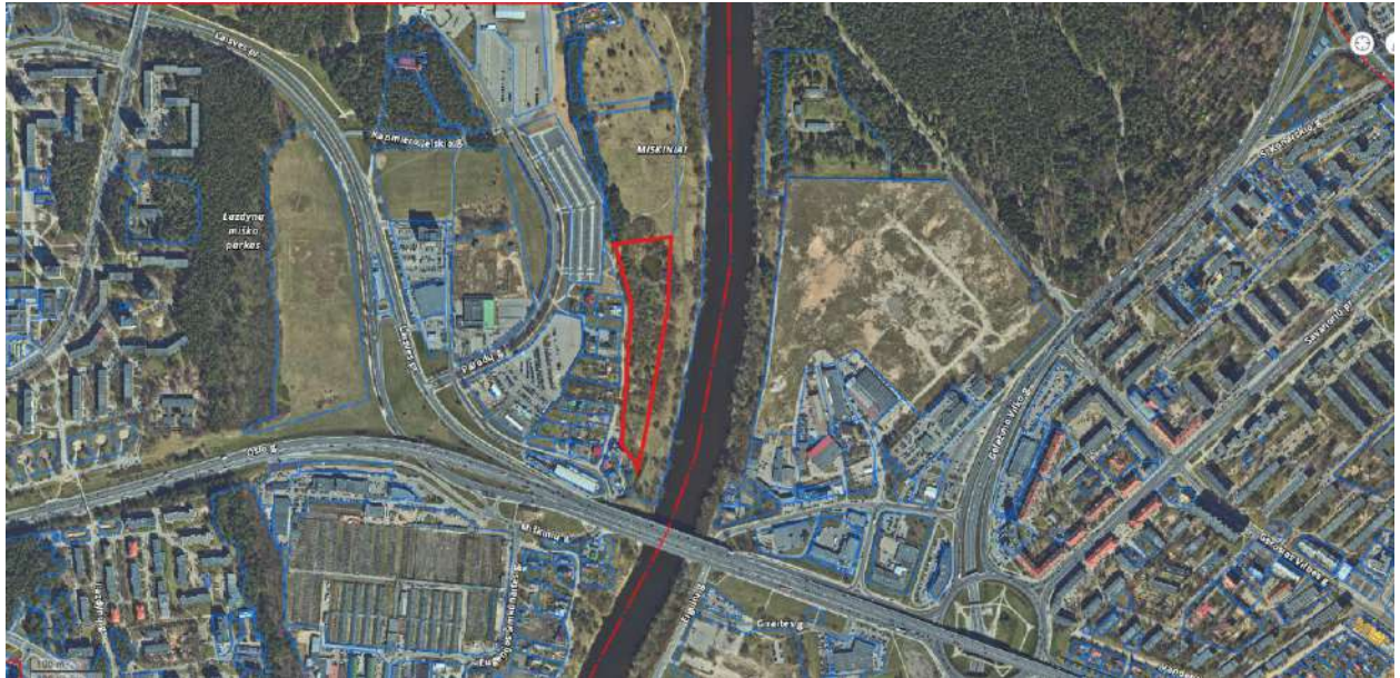
1 pav. Statybos vieta
