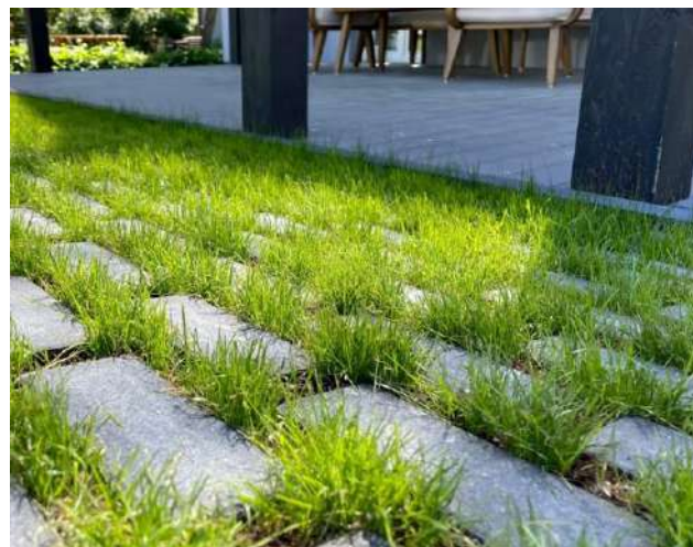
21-22 pav. Mišrios pėsčiųjų tako dangos analogas: dalis tako įrengiama naudojant betonines trinkeles, dalis tako pakraščių įrengiami naudojant drenuojančio tipo ažūrines trinkeles, tarpus užsėjant žole
