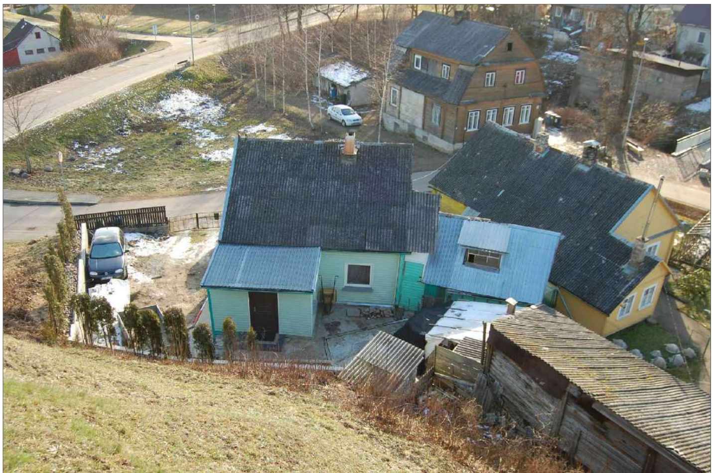
4 pav. Vaizdas iš šiaurės pusės
