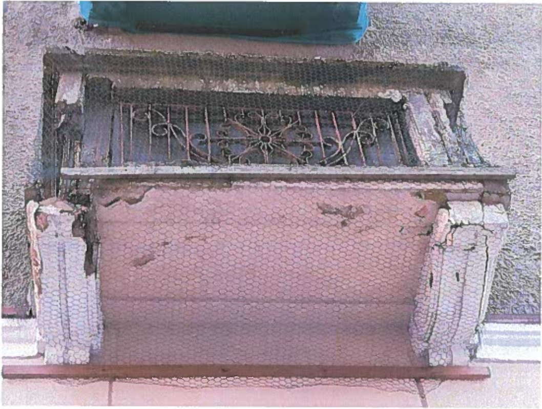
2.5 pav. Atidengtos metalinės konstrukcijos
