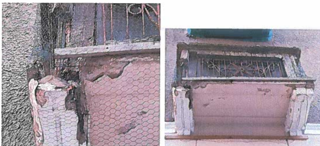
3.2 pav. Atidengtos metalinės konstrukcijos
