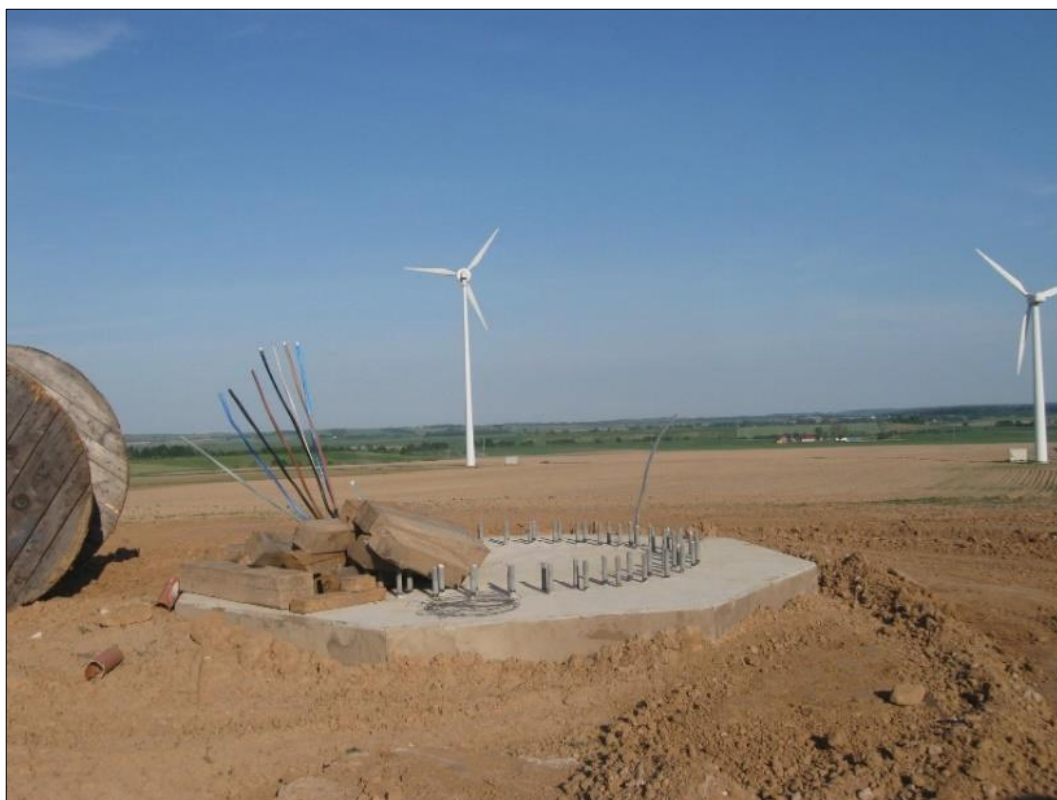
3.2.7.4 pav. VE pamatas, statant plieninį stiebą
