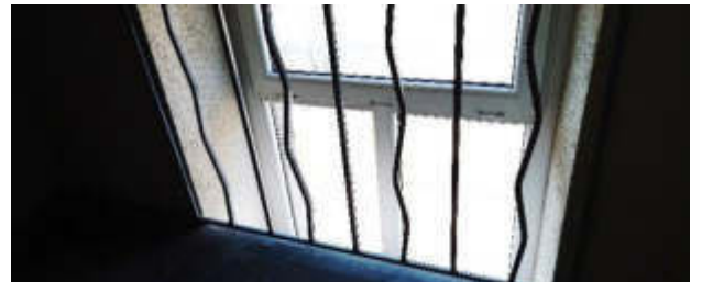
7 pav. Nesaugūs laiptų turėklai ir langų apsauginiai aptvarai – tarp vertikalių elementų per dideli plyšiai.
