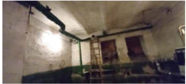
10 pav. Netvarkinga, nesandari lietaus nuvedimo sistema – korduoja, tikėtina dėl užsikimšusio vamzdyno lietvamzdis atjungtas nuo lietaus kanalizacijos tinklų.
