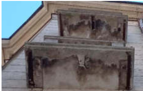
3 pav. Dalies balkonų tinko/betono sluoksnis aptrupėjęs, matosi stipriai korozijos pažeistas armatūros tinklas. Balkono plokščių betonai pajuodę, hidroizoliacija nusidėvėjusi, arba jos visai nėra – dėl to balkono plokštės nuolat veikiamos drėgmės. Kai kurie balkonai turi avarinės būklės požymių.
