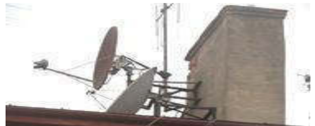
8 pav. Dalies ventiliacinių kaminų tinkas vietomis nubyrėjęs, apiręs, mūras paveiktas erozijos, yra, neapskardintos kaminų viršutinės dalys. Ant kaminų montuojamos antenos.
