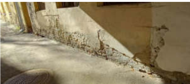
2 pav. Pastato cokolinės dalies apsauginis tinkas vietomis apiręs, atšokęs, nubyrėjęs. Cokolio plytų mūras paveiktas erozijos, ištrupėjusios siūlės, yra įtrūkių.
