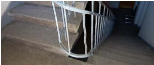
7 pav. Nesaugūs laiptų turėklai ir langų apsauginiai aptvarai – tarp vertikalių elementų per dideli plyšiai.
