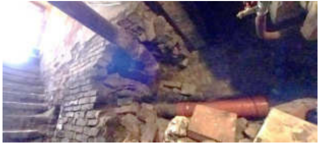
10 pav. Netvarkinga, nesandari lietaus nuvedimo sistema – korduoja, tikėtina dėl užsikimšusio vamzdyno lietvamzdis atjungtas nuo lietaus kanalizacijos tinklų.
