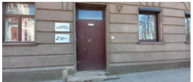
2 pav. Pastato cokolinės dalies apsauginis tinkas vietomis apiręs, atšokęs, nubyrėjęs. Cokolio plytų mūras paveiktas erozijos, ištrupėjusios siūlės, yra įtrūkių.
