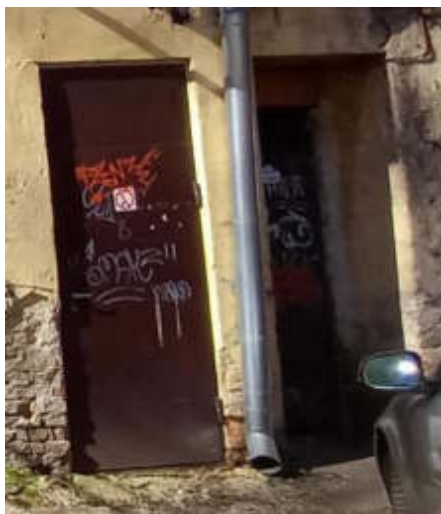
5 pav. Nusidėvėjusios, nesandarios, laiptinių ir rūšio durys. Šilumos punkte rūšio langai užkalti.
