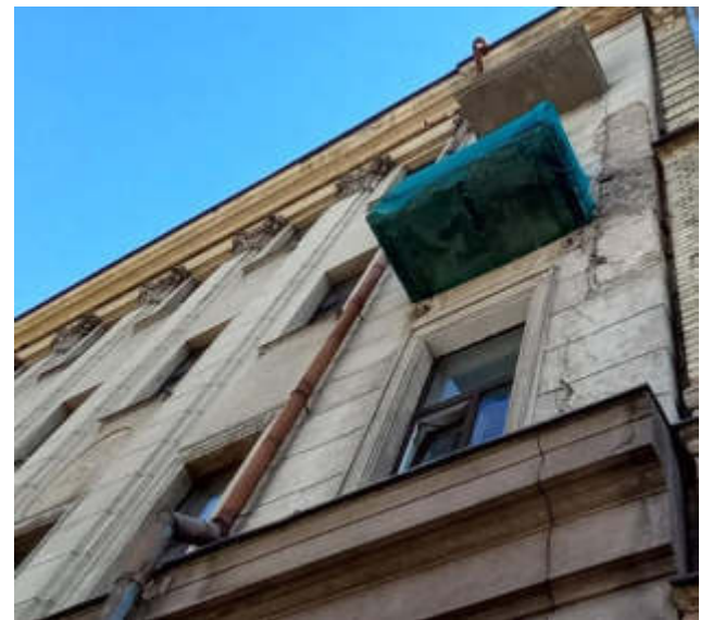
4 pav. Nusidėvėjęs fasadas – apsauginis tinkas vietomis apiręs, atšokęs, nubyrejęs. daugelyje vietų matomi įtrūkiiai. Gatvės pusėje esančių atsikišusių fasado elementų apskardinimai pažeisti korozijos. Dėl netvarkingos lietaus nuvedimo sistemos, vanduo drėkina pastato konstrukcijas ir jas ardo.
