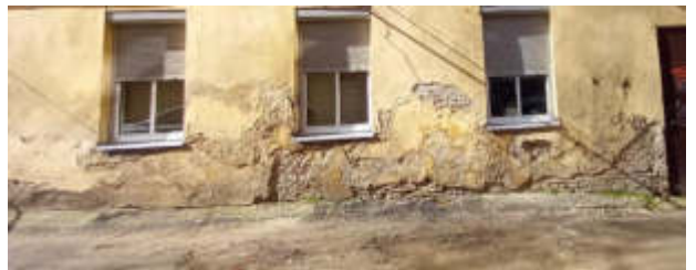
1 pav. Aptrupėję, apirę pastato karnizai, dekoru detalės. Išorinės metalinės kopėčios koroduoja, neturi apsauginių aptvarų – nesaugu vykdyti stogo eksploatacinę priežiūrą.
