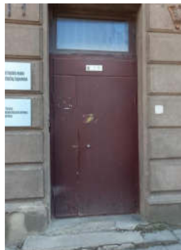
5 pav. Nusidėvėjusios, nesandarios, laiptinių ir rūšio durys. Šilumos punkte rūšio langai užkalti.
