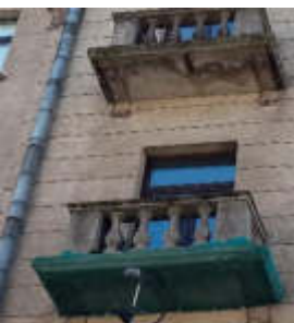
3 pav. Dalies balkonų tinko/betono sluoksnis aptrupėjęs, matosi stipriai korozijos pažeistas armatūros tinklas. Balkono plokščių betonai pajuodę, hidroizoliacija nusidėvėjusi, arba jos visai nėra – dėl to balkono plokštės nuolat veikiamos drėgmės. Kai kurie balkonai turi avarinės būklės požymių.
