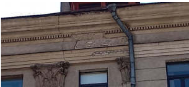
1 pav. Aptrupėję, apirę pastato karnizai, dekoru detalės. Išorinės metalinės kopėčios koroduoja, neturi apsauginių aptvarų – nesaugu vykdyti stogo eksploatacinę priežiūrą.
