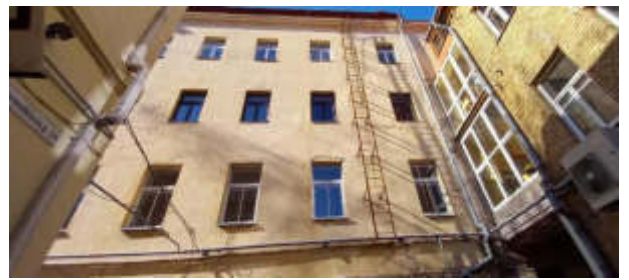
1 pav. Aptrupėję, apirę pastato karnizai, dekoru detalės. Išorinės metalinės kopėčios koroduoja, neturi apsauginių aptvarų – nesaugu vykdyti stogo eksploatacinę priežiūrą.
