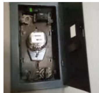
9 pav. Magistraliniai laidai susidėvėję, dėl padidėjusios el. energijos vartojimo galimai neužtikrinama saugi eksploatacija.
