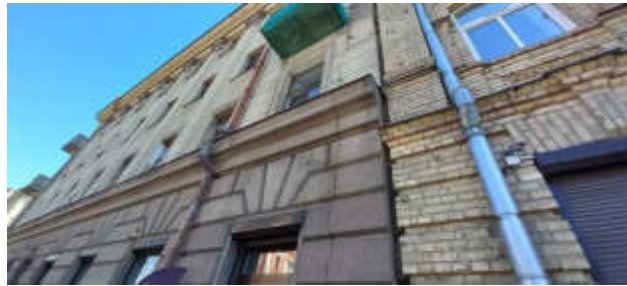
10 pav. Netvarkinga, nesandari lietaus nuvedimo sistema – korduoja, tikėtina dėl užsikimšusio vamzdyno lietvamzdis atjungtas nuo lietaus kanalizacijos tinklų.
