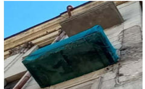
3 pav. Dalies balkonų tinko/betono sluoksnis aptrupėjęs, matosi stipriai korozijos pažeistas armatūros tinklas. Balkono plokščių betonai pajuodę, hidroizoliacija nusidėvėjusi, arba jos visai nėra – dėl to balkono plokštės nuolat veikiamos drėgmės. Kai kurie balkonai turi avarinės būklės požymių.
