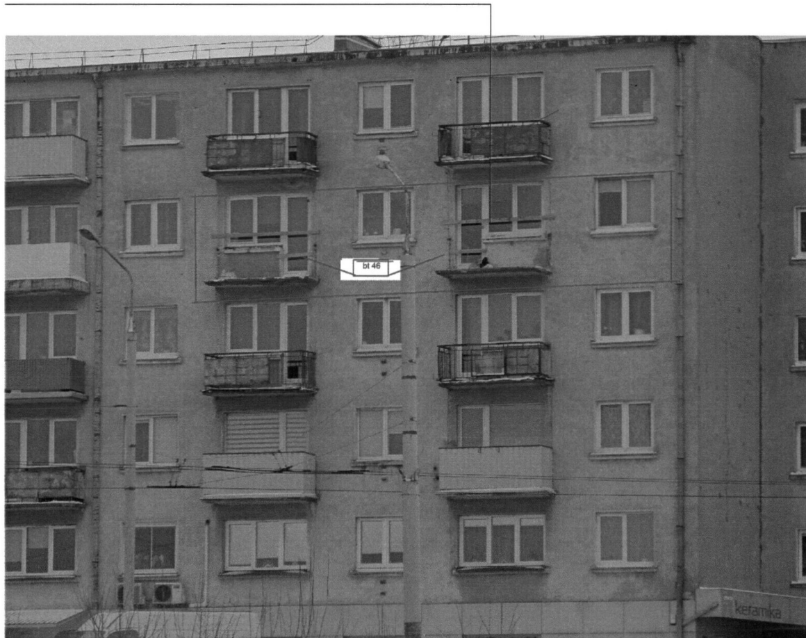
SAVANORIŲ PR. FASADAS. REMONTUOJAMŲ BALKONŲ VIETA
