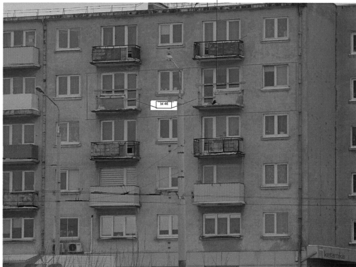
SAVANORIŲ PR. FASADAS. REMONTUOJAMŲ BALKONŲ VIETA
