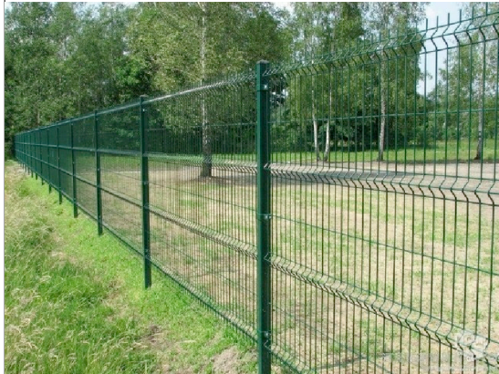
Projektuojama tvora Nr. 2: Fasadinė tvora, vartai ir varteliai - metalinių vertikalių "šukų", spalva RAL 7021; aukštis - iki 1.5m.; ažūriškumas - 75proc., saulės šviesos pralaidumas;
