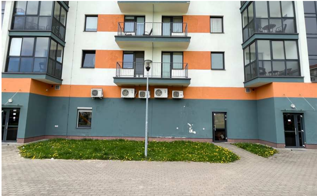
6 pav. III korpusas, rytinis fasadas: I a. tarp laiptinių (butai 25-48 ir 1-25) dalyje atšokęs tinkas
