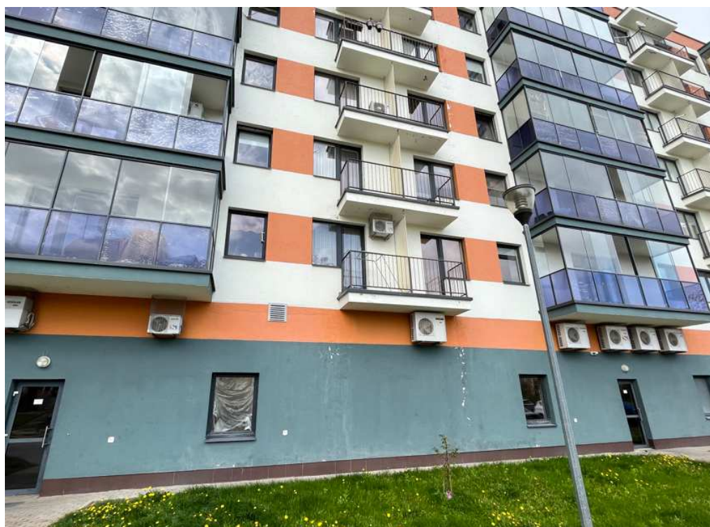
24 pav. I korp. pietinis fasadas: tarp 3 ir 2 laiptinių tinko pažaidų vaizdas
