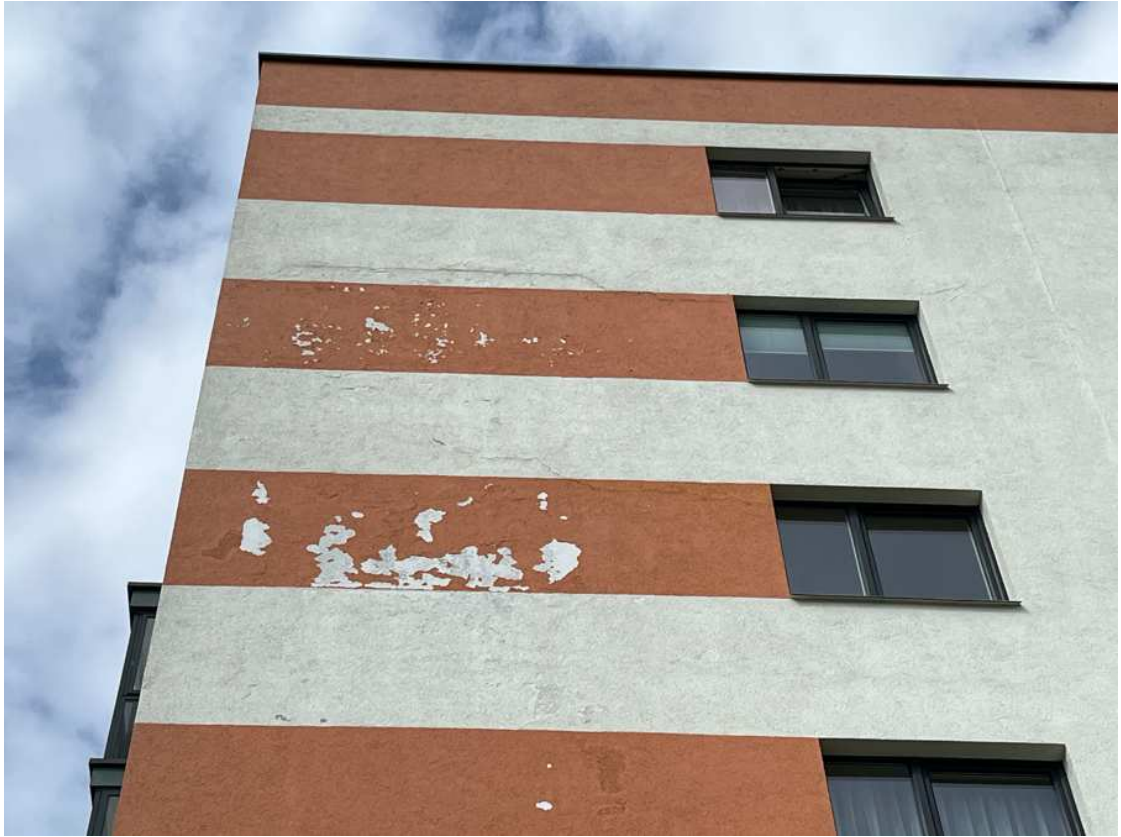
9 pav. III korpusas, pietinis fasadas: suirusio tinko vaizdas
