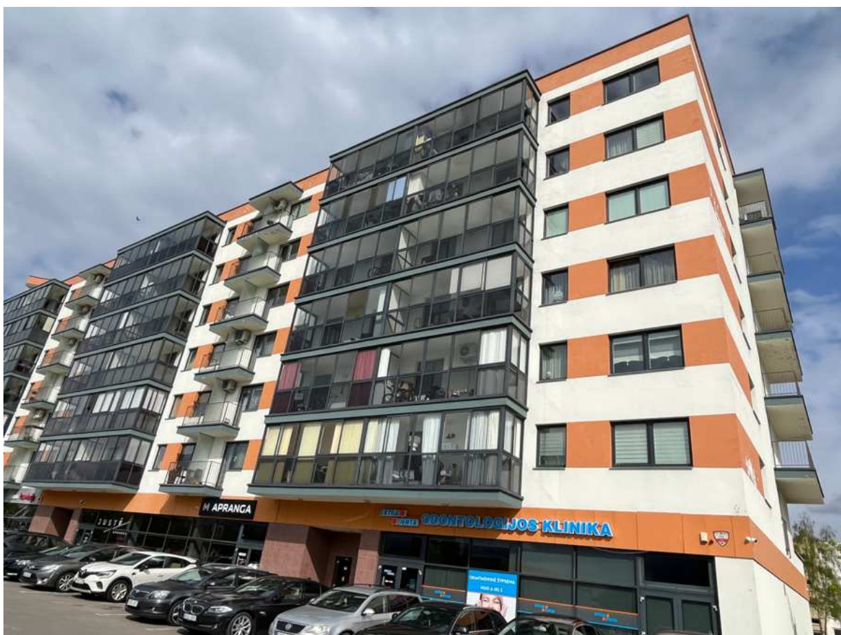
11 pav. III korpusas, vakarinio fasado bendras vaizdas
