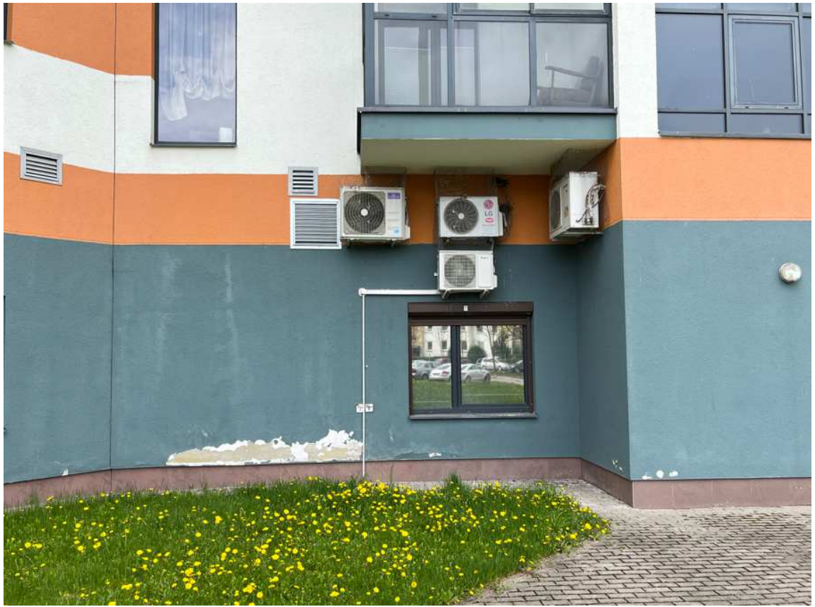
15 pav. II korp., rytinis fasadas: I a. laiptinės (butai 57-88) tinko pažaidos
