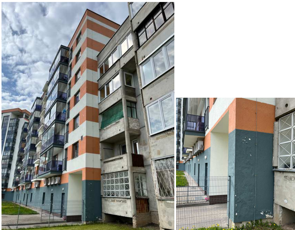
28 pav. I korp. rytinis fasadas: 1 laiptinės tinko pažaidų vaizdas
