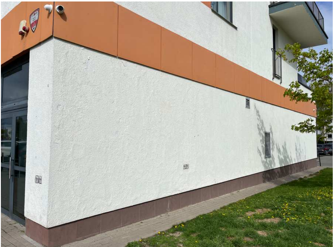
10 pav. III korpusas, pietinis fasadas: ties I a. suirusio tinko vaizdas
