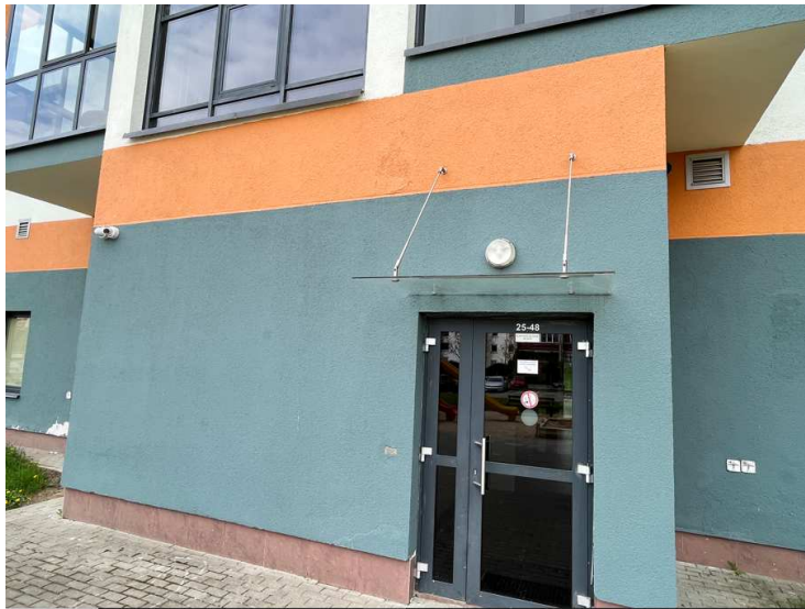
5 pav. III korpusas, rytinis fasadas: I a. laiptinės (butai 25-48) dalyje atšokęs tinkas
