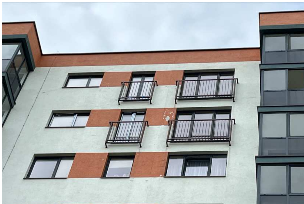
17 pav. II korp., rytinis fasadas: tarp laiptinių (butai 57-88 ir 33-56) ties VI ir VII aukštais tinko pažaidos
