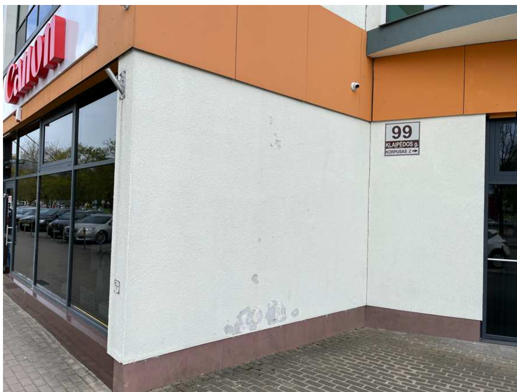
29 pav. I korp. vakarinis fasadas: 3 laiptinės tinko pažaidų vaizdas
