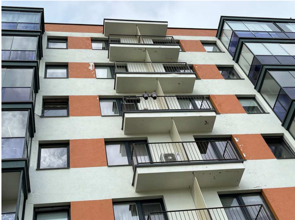
25 pav. I korp. pietinis fasadas: tarp 3 ir 2 laiptinių tinko pažaidų vaizdas
