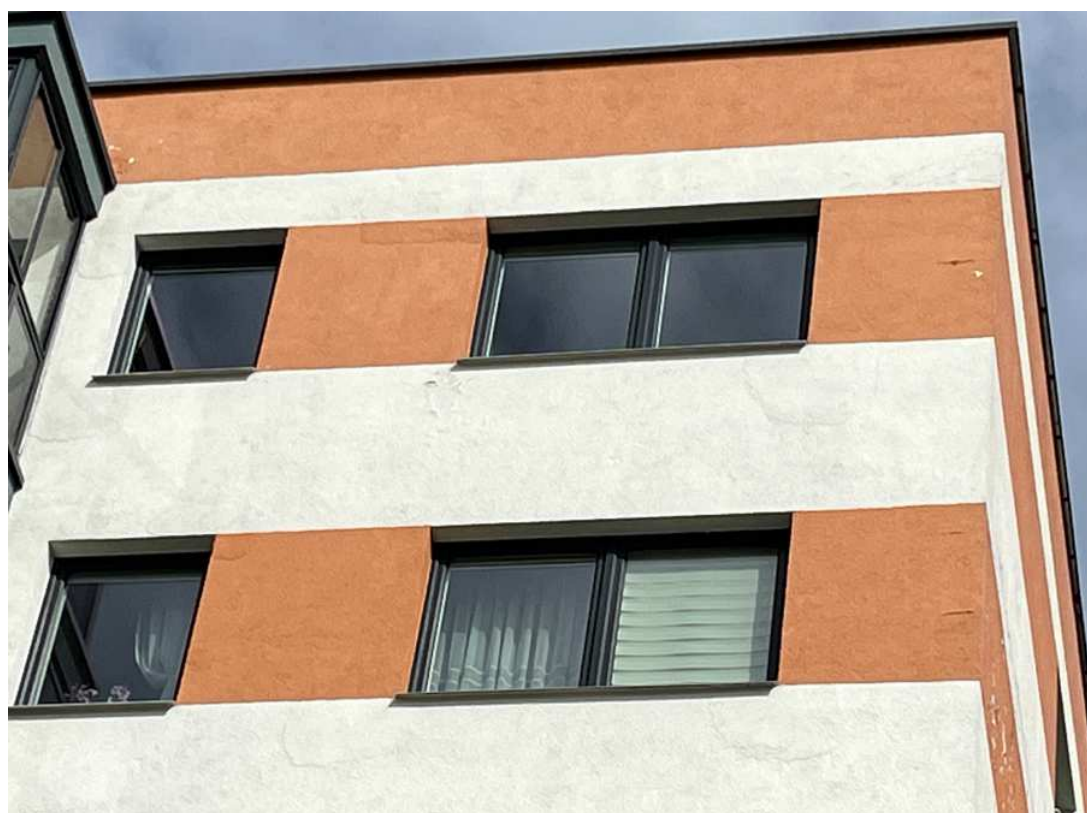
12 pav. III korpusas, vakarinis fasadas: ties VII a. atšokusio tinko vaizdas
