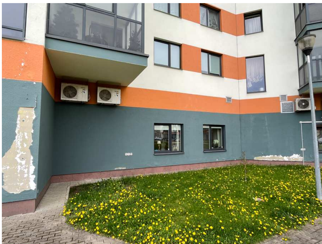
7 pav. III korpusas, rytinis fasadas: I a. laiptinės (butai 1-25) dalyje atšokęs tinkas
