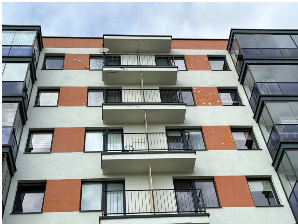
27 pav. I korp. pietinis fasadas: 1 laiptinės tinko pažaidų vaizdas
