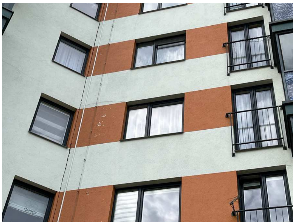
23 pav. I korp. pietinis fasadas: ties IV a. tinko pažaidos vaizdas
