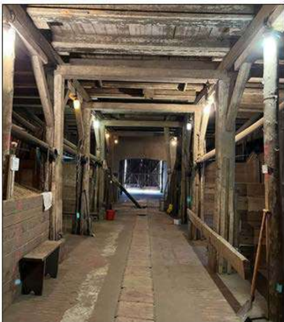
Pirmojo aukšto medinės konstrukcijos nepakitusios, vietomis sustiprintos
