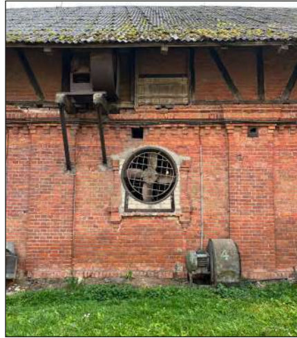
Arklidės fasadai yra aplipdyti technika, angos užmūrytos, pakeistos
