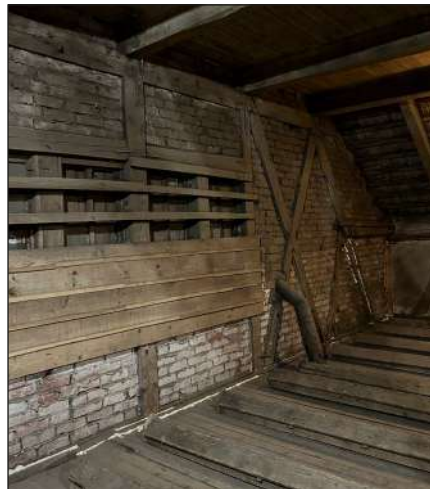
Antrajame aukšte likę Vento gatvės fasado likučiai – medinė konstrukcija, angos
