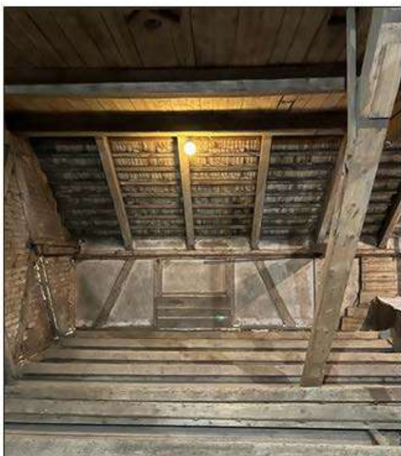
Vietomis gerai išsilaikiusi stogo konstrukcija
