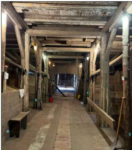
Pirmojo aukšto medinės konstrukcijos nepakitusios, vietomis sustiprintos
