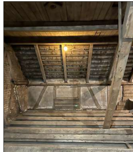
Vietomis gerai išsilaikiusi stogo konstrukcija; aukštas yra tamsus – nė vieno lango
