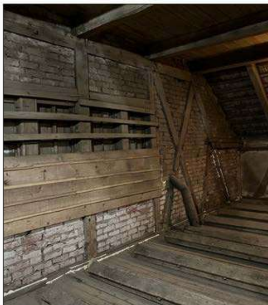
Antrajame aukšte likę Ventos gatvės fasado likučiai – medinė konstrukcija, angos
