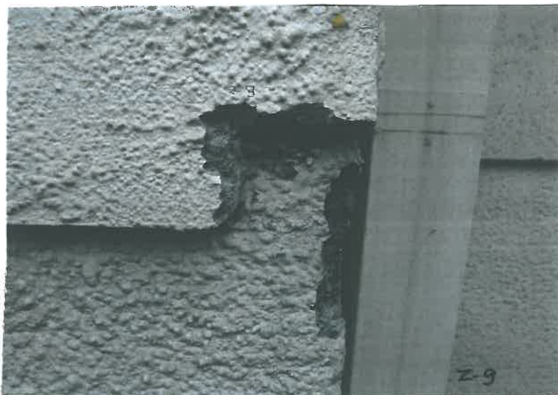
F-7. Zondažas Z-9, vėliau suformuotos architektūrinės detalės
