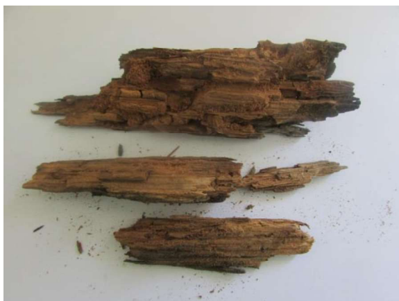
1 pav. Atvežtų medinių konstrukcijų Nr. 1 bendras vaizdas
