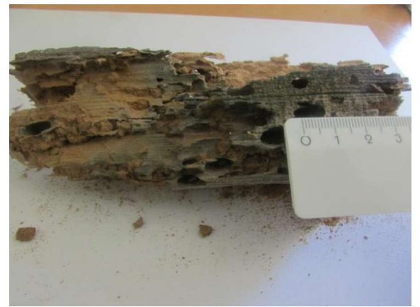
9 pav. Atvežtos medinės konstrukcijos Nr. 4 pažeistos entomologinių kenkėjų
