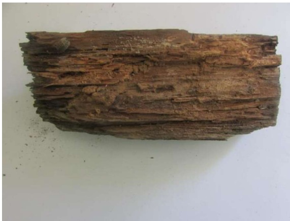
6 pav. Atvežtų medinių konstrukcijų Nr. 3 bendras vaizdas
