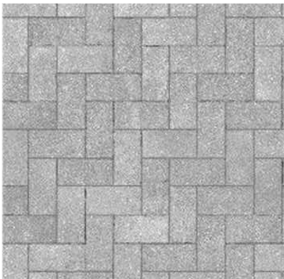
Gatvės trinkelės. Trinkelų danga sutvirtintu gruntu
