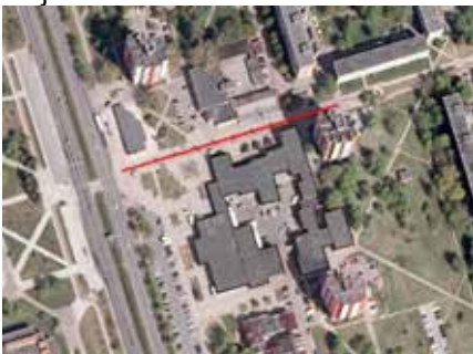
Visuomeninės paskirties pastatas su prekybinėmis patalpomis Taikos pr. 101
