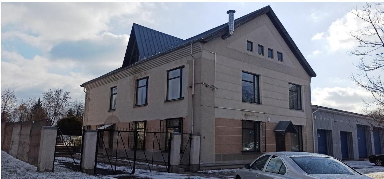
3 pav. Rekonstruojamas pastatas
