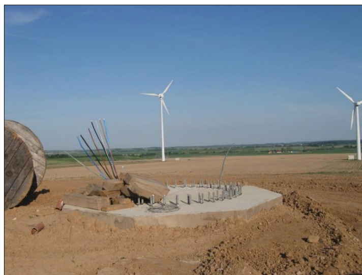
5.4 pav. VE pamatas, statant plieninį stiebą
