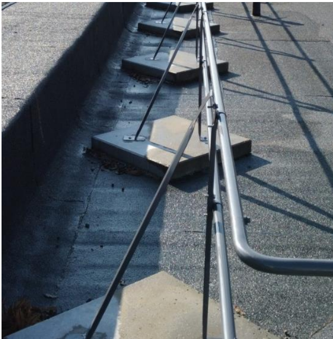
Principinis tvorelės įrengimo variantas, nepažeidžiant stogo dangos.
