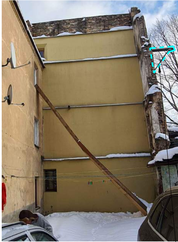
Išlikusios buvusio balkono konstrukcijos
