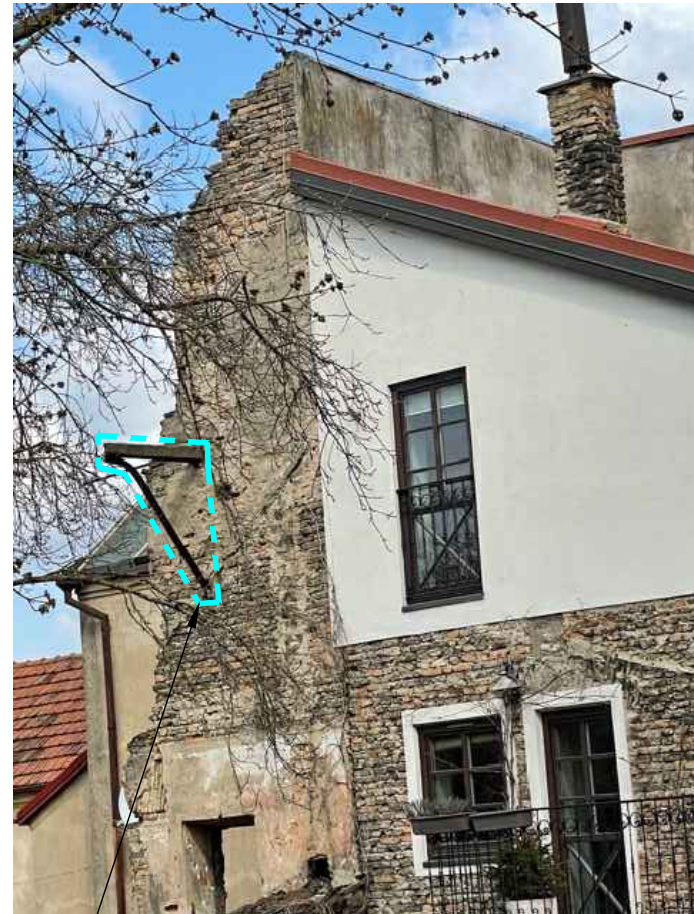
Išlikusios buvusio balkono konstrukcijos
