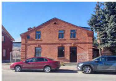
Rekonstravimo darbai - didamos langų angos
