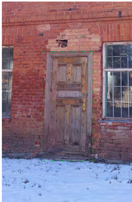
Rekonstravimo darbai - užmūrijama anga (nevertingos durys)
