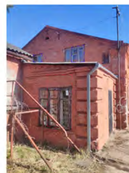
Rekonstravimo darbai - perkeliama lango anga po prieštine sąrama.
