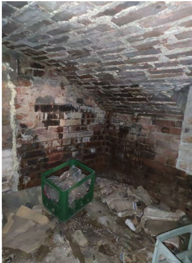
Tvarkybos darbai - išsaugojamos esamo rūsio laikančiosios sienos ir skliautas
