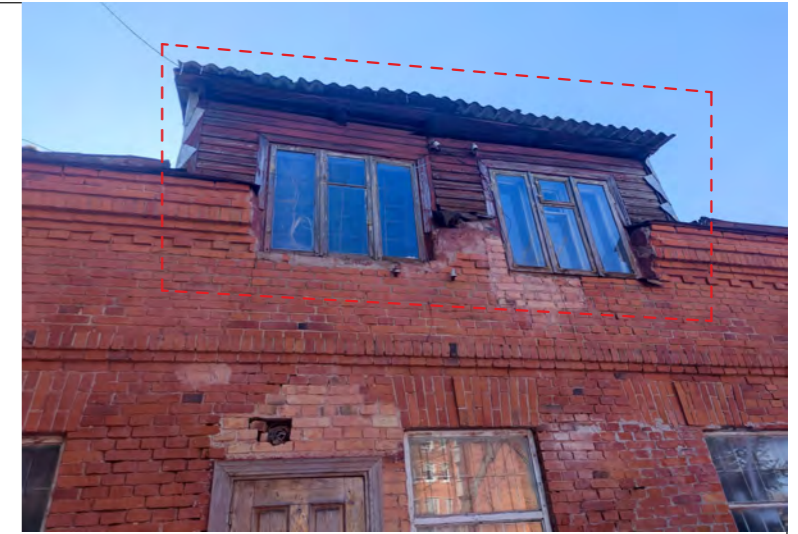
Rekonstravimo darbai - naikinama ir projektuoma nauja centruota mansarda, analogiška pietinėje pusėje esančiam mezoninui.
