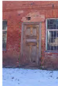
Rekonstravimo darbai - užmūrijama anga (nevertingos durys)
