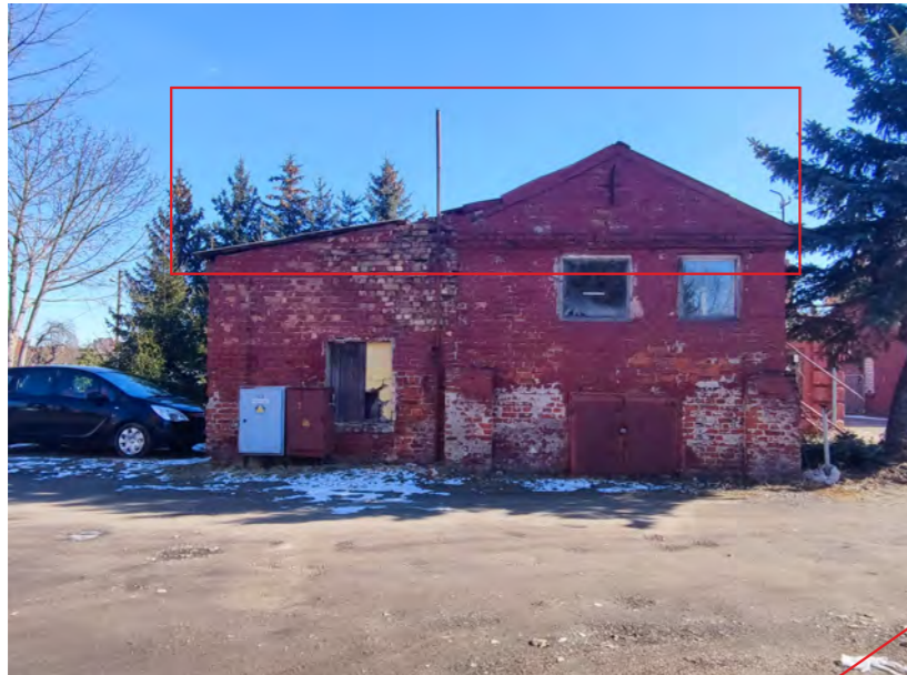
Rekonstravimo darbai - naikinami stogai ir projektuojamas bendras dvišlaitis stogas.
