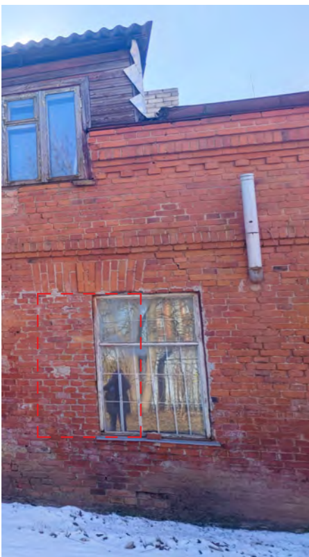
Rekonstravimo darbai - perkeliama anga po pleištime sąrama
