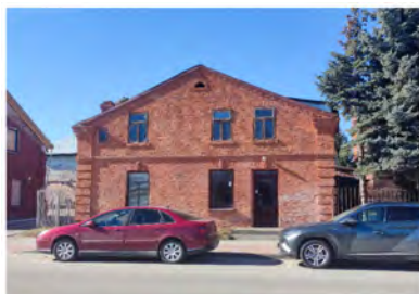
Rekonstravimo darbai - didamos langų angos.
