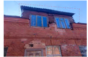
Rekonstravimo darbai - naikinama ir projektuoma nauja centruota mansarda, analogiška pietinėje pusėje esančiam mezoninui.
