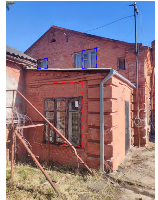
Rekonstravimo darbai - perkeliama lango anga po pleištinę sąramą
