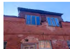
Rekonstravimo darbai - naikinama ir projektuojama nauja centrinė mansarda, analogiška pietinėje pusėje esančiam mezoninui
