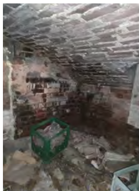
Tvarkybos darbai - išsaugojamos esamo rūšio laikančios sienos ir skliautas
