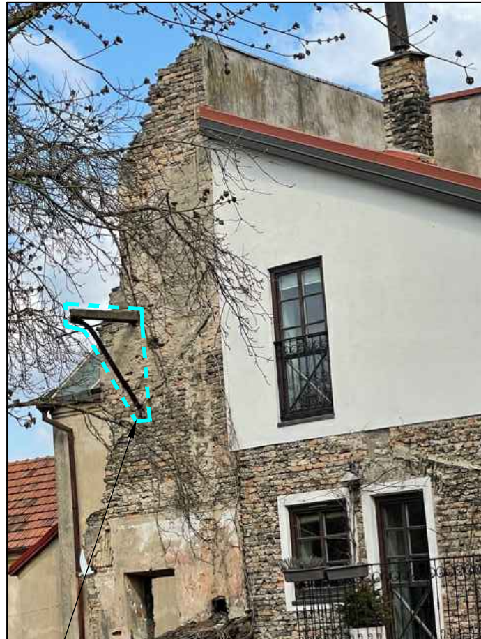
Išlikusios buvusio balkono konstrukcijos
