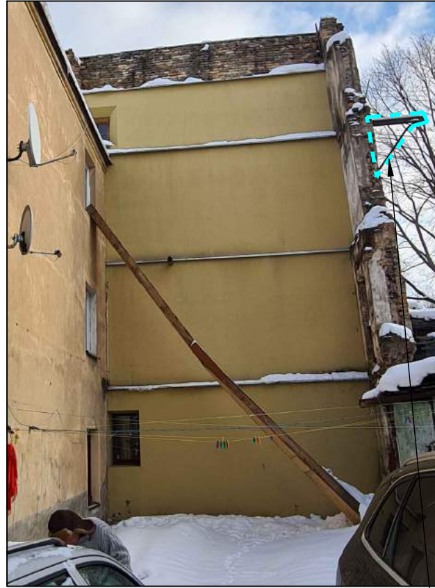
Išlikusios buvusio balkono konstrukcijos
