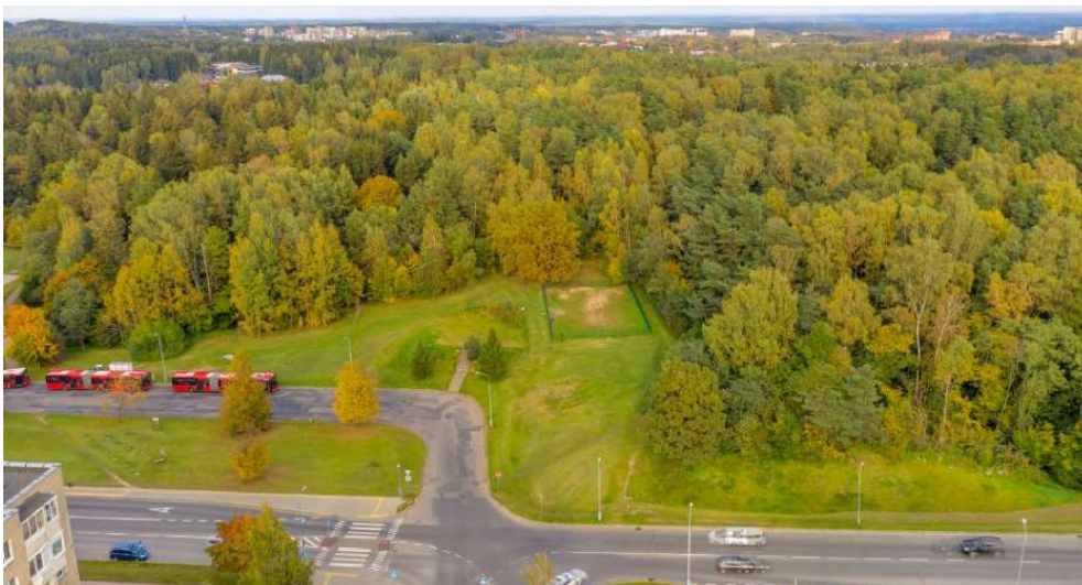
pav. 2 Esamos situacijos fotofiksacija
