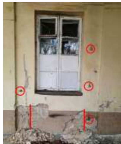
C Buvusi durų anga su išlikusiais vinių kabilais ir spynos pakabinimu
