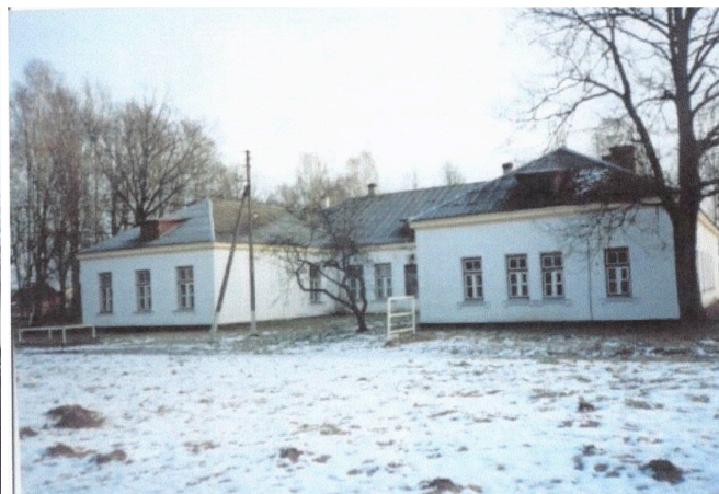
2003 m. mokyklos fotofiksacija. Šiaurinis fasadas (iki pastato rekonstrukcijos)
