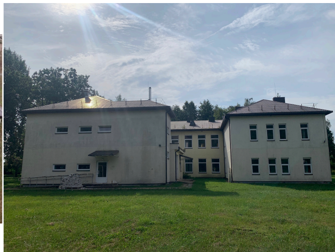
2022 m. mokyklos fotofiksacija. Šiaurinis fasadas (po pastato rekonstrukcijos)
