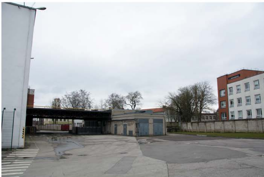
12. PRODUKCIJOS PAKAVIMO IR TRANSFORMATORINĖS PASTATAS
