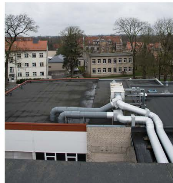
15. PRODUKCIJOS PAKAVIMO IR TRANSFORMATORINĖS PASTATAS (VAIZDAS NUO GAMYBINIO PASTATO STOGO)
