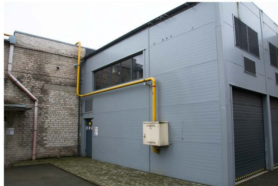
13. PRODUKCIJOS PAKAVIMO IR TRANSFORMATORINĖS PASTATAS
