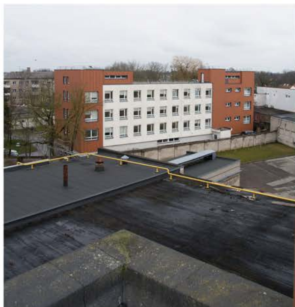
14. PRODUKCIJOS PAKAVIMO IR TRANSFORMATORINĖS PASTATAS (VAIZDAS NUO GAMYBINIO PASTATO STOGO)
