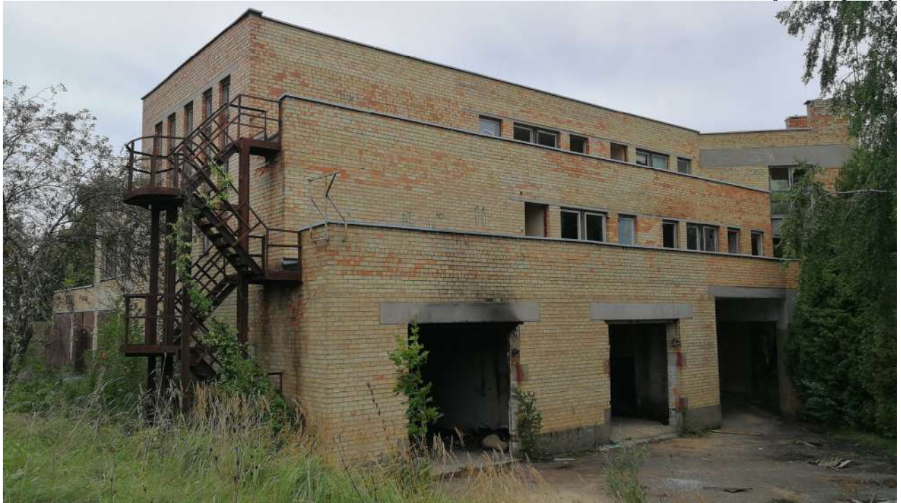
5 pav. Esama atvira metalinė laiptinė
