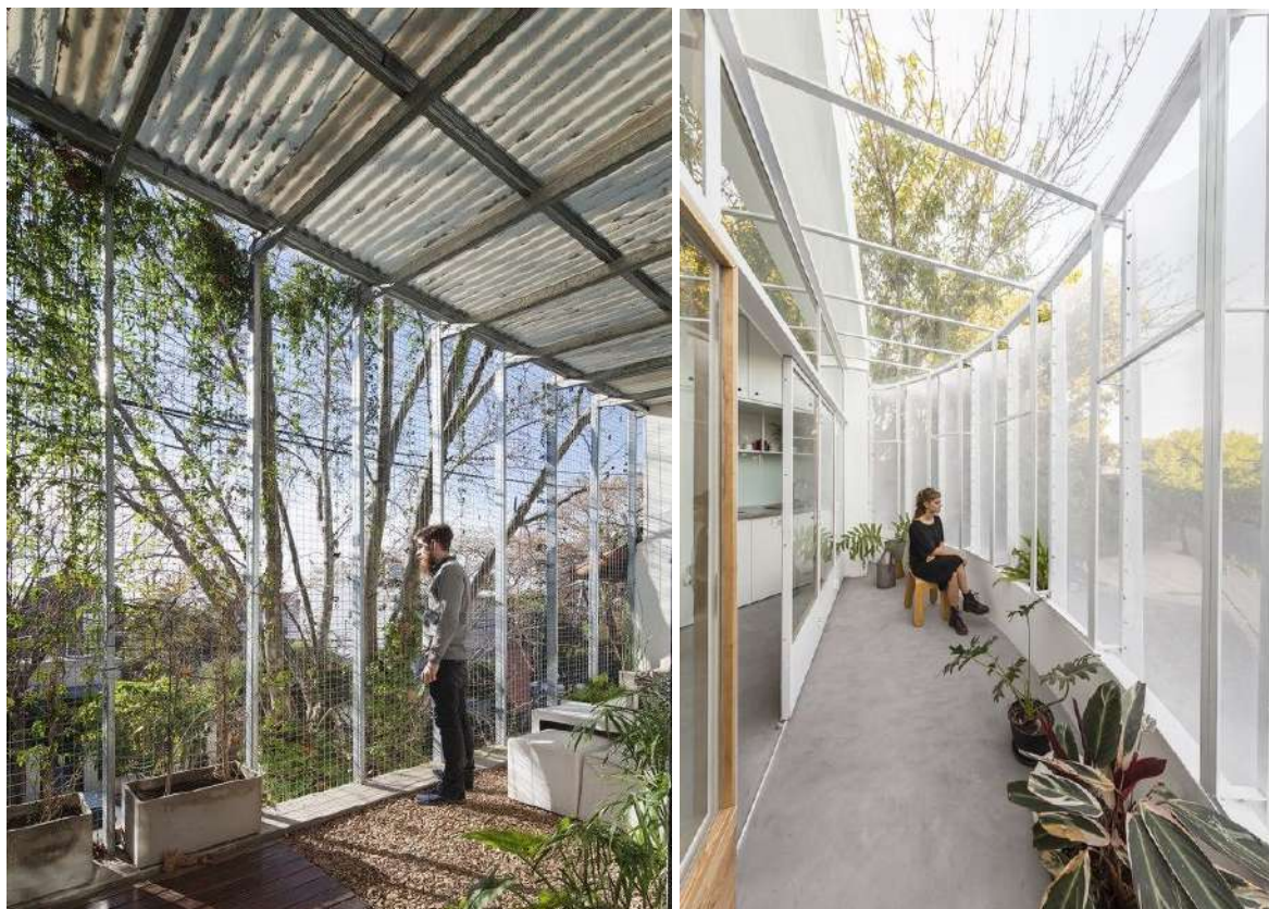
7-8 pav. Balkonų aptvėrimo ir pritaikymo pavyzdžiai
