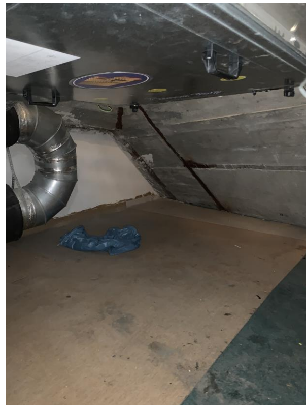
Esamos situacijos fotografavimas. Esama stogo konstrukcija viešbučio dalyje. Stogas - GB konstrukcija
