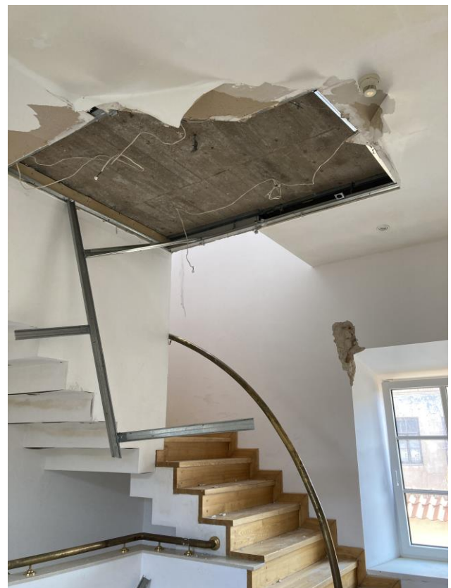
Esamos situacijos fotografacija. Esanti perdanga tarp 2a ir pastogės yra gelžbetoninė, įrengta apie 2002m.
