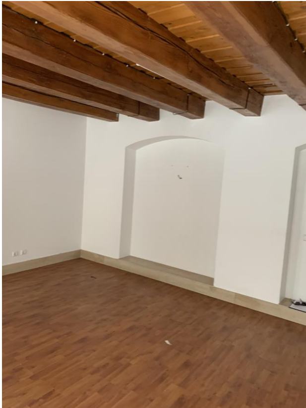
Esamos situacijos fotografacija. I aukšto patalpos, perdanga tarp 1-2aukšto (tarp buto ir administracinių patalpų). Esama perdanga medinė, įrengta XXa.pab. Apie 2002m. remontuota, sutvirtinta metalo sijomis.
