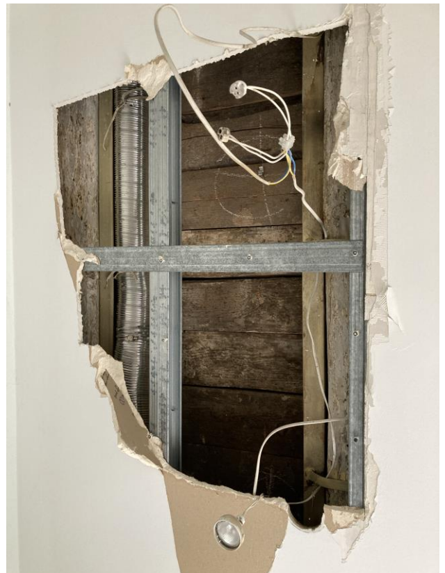
Esamos situacijos fotografacija. I aukšto patalpos, perdanga tarp 1-2aukšto (tarp buto ir administracinių patalpų). Esama perdanga medinė, įrengta XXa.pab. Apie 2002m. remontuota, sutvirtinta metalo sijomis.
