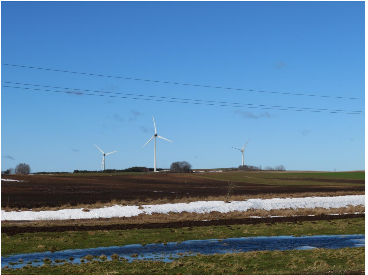
20 pav. Vėjo elektrinės greta Norvydų gyvenvietės
