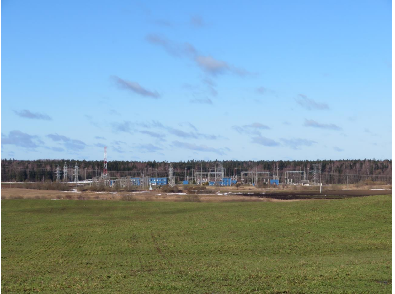
5 pav. Greta vėjo elektrinių statybos teritorijos esama aukštos įtampos elektros skirstykla
