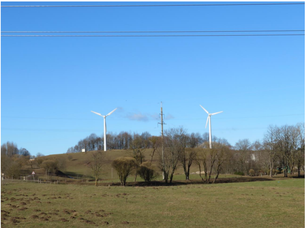
19 pav. Esamos dvi mažosios vėjo elektrinės
