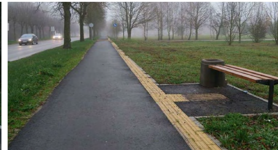
Pėsčiųjų takas su asfaltbetonio danga pritaikytas ŽN
