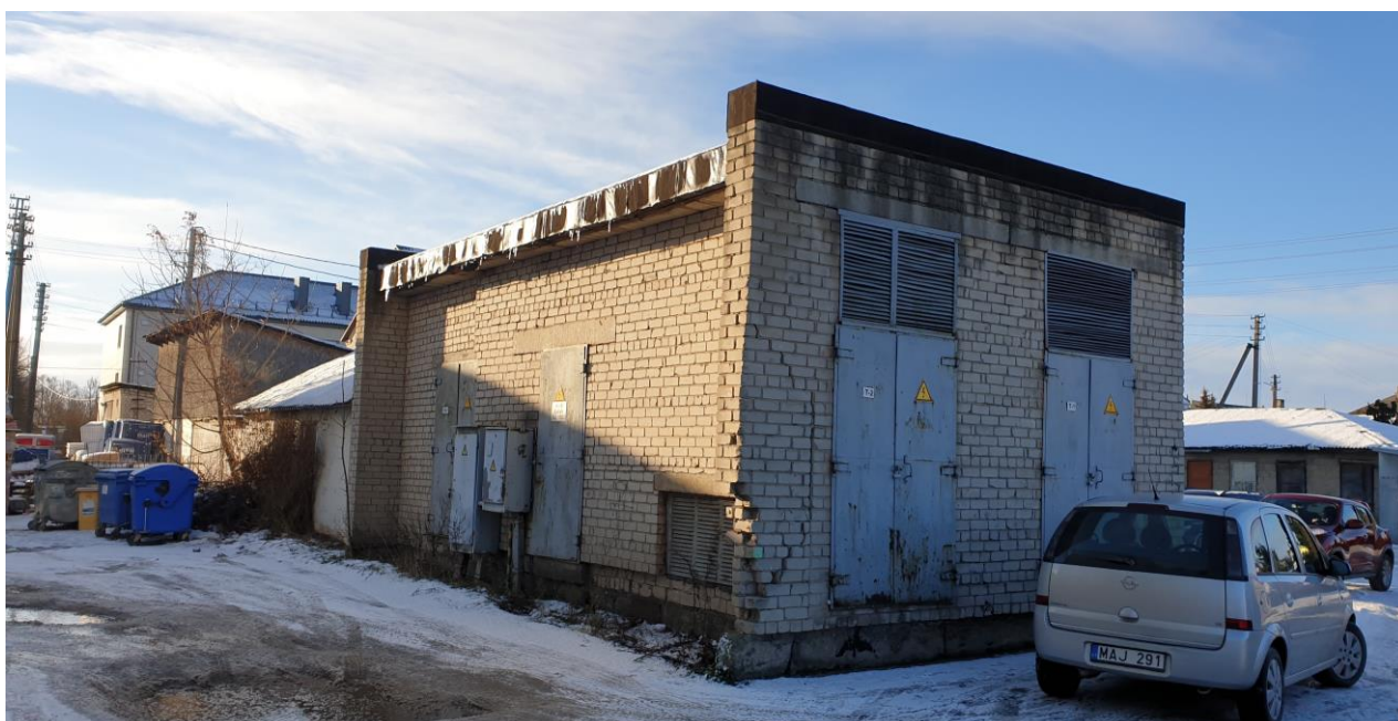
Nuotrauka Nr. 4 „Esamos būklės fotofiksacija. Kiemo statinys - transformatorinė“
