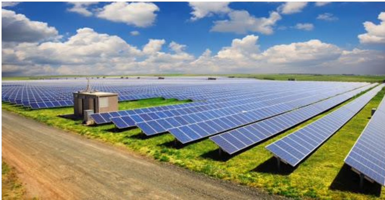
2.2.2 pav. Saulės modulių sekcijų įrengimo žemės paviršiuje pavyzdys.
