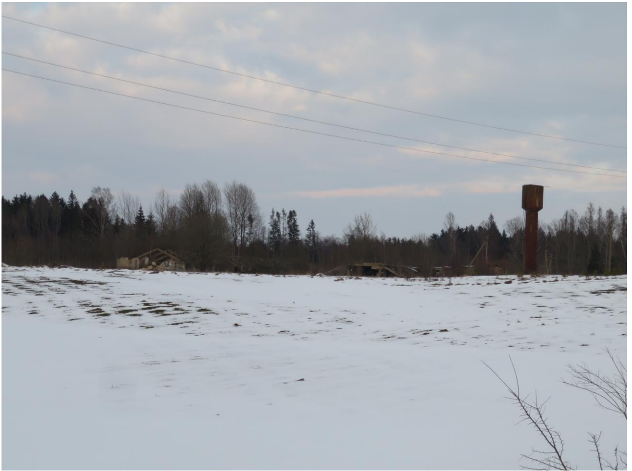
26 pav. Dotenėnų kaimo gretimybėse buvęs sovietmečio fermų kompleksas ir vandentiekio bokštas
