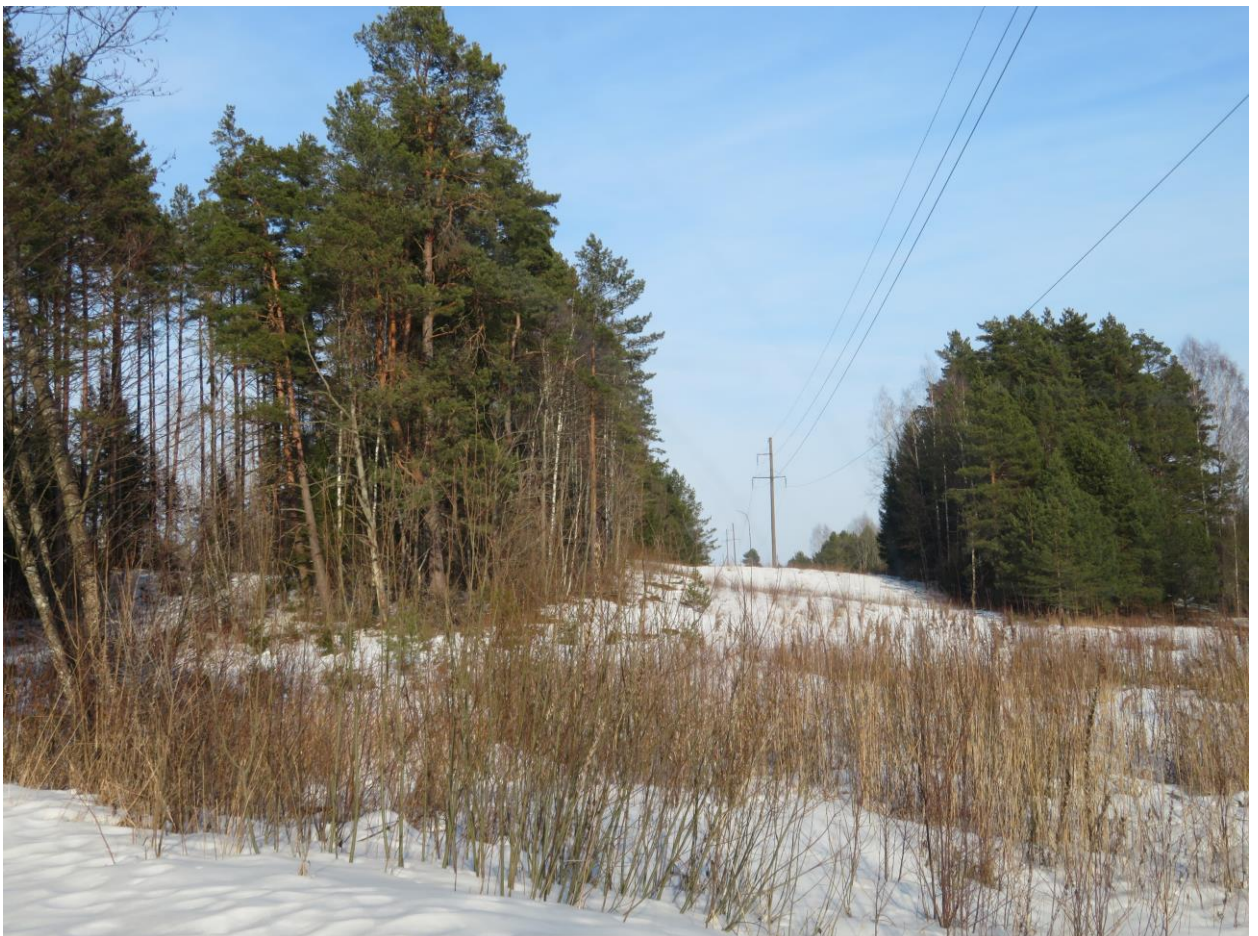
8 pav. Esama 110 kV orinė elektros perdavimo linija
