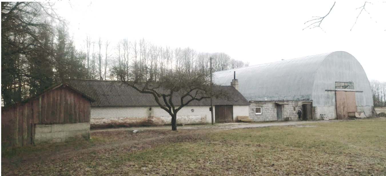
2 pav. Fotofiksacija (vaizdas iš Šiaurės vakarų pusės)
