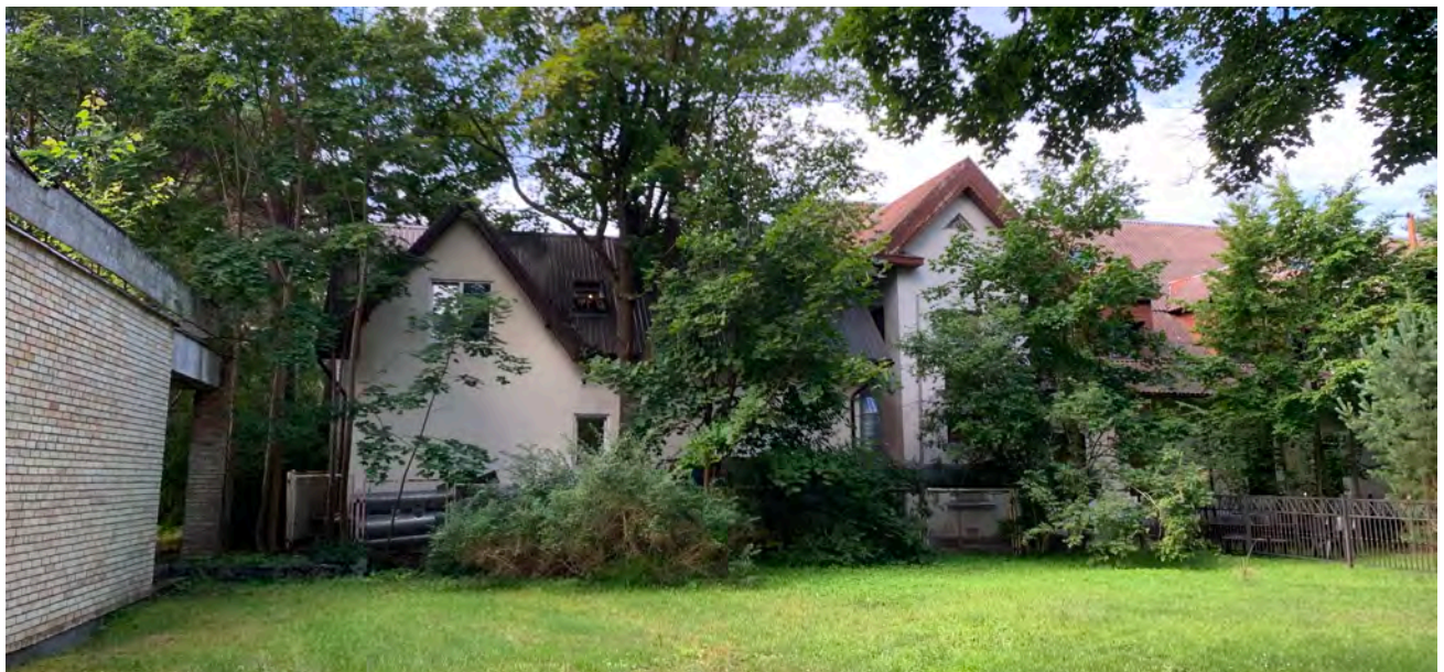
"Vandenis". Šiaurinis fasadas. Birutės al. 47
