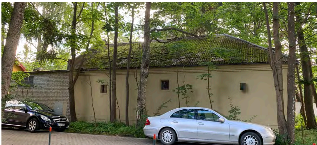
Ūkinis pastatas ir transformatorinė pastotė. Kęstučio 19A ir Kęstučio 19T
