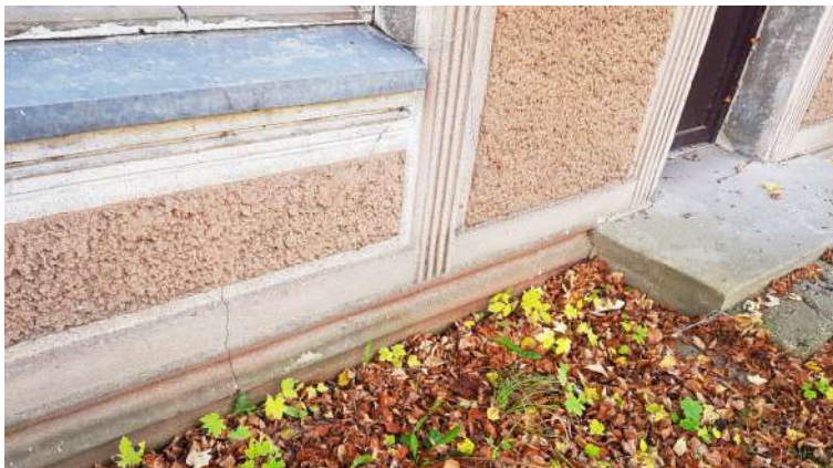
11 pav. Pastato rytinio fasado fragmentas, cokolis. 2021 m. lakričio mėn.
