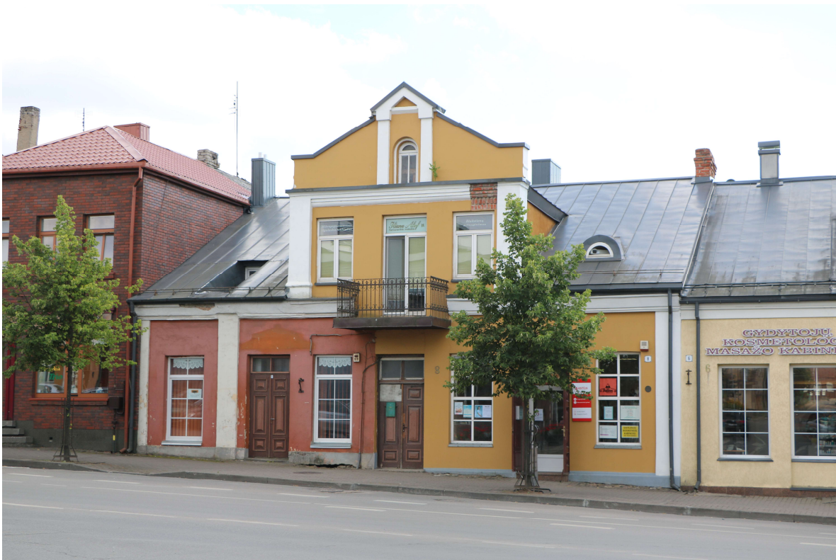
2 pav. Turgaus a.8 pastato, šiaurinis ( gatvės ) fasadas. Fotofiksacija Nr.1
