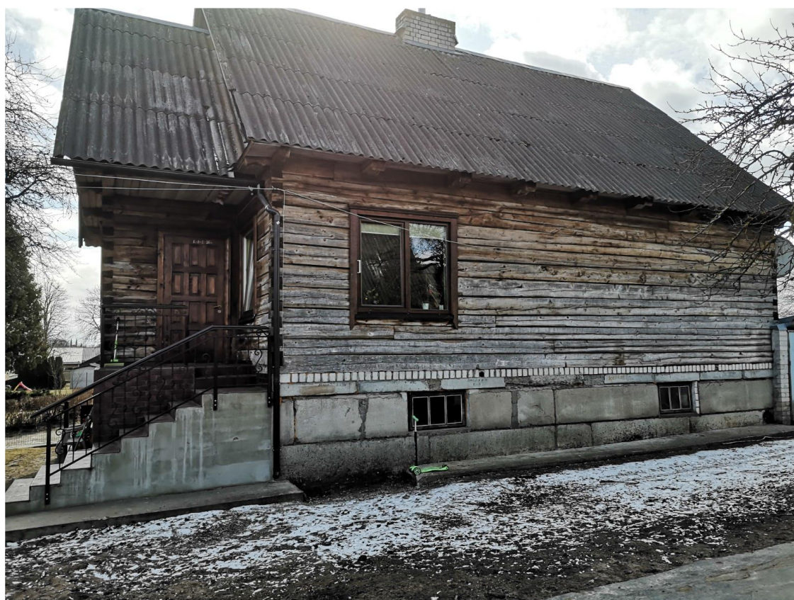
5. pav. Šiaurinis fasadas
