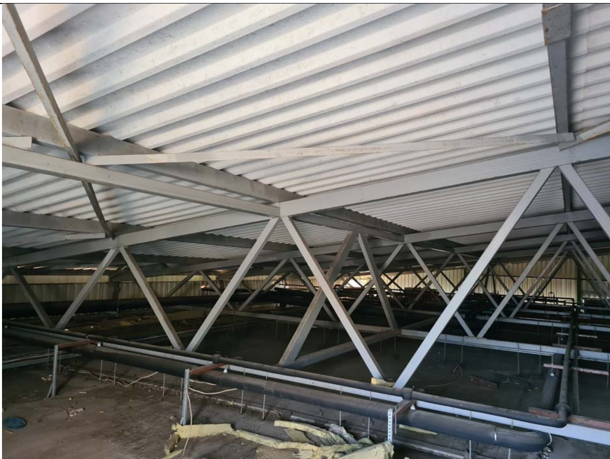
203 pav. Pastato Nr.1.2. stogo konstrukcijų fotofiksacija ir apmatavimai. Denginio konstrukcijų matmenys atitinka nurodytus archyvineame projekte.
