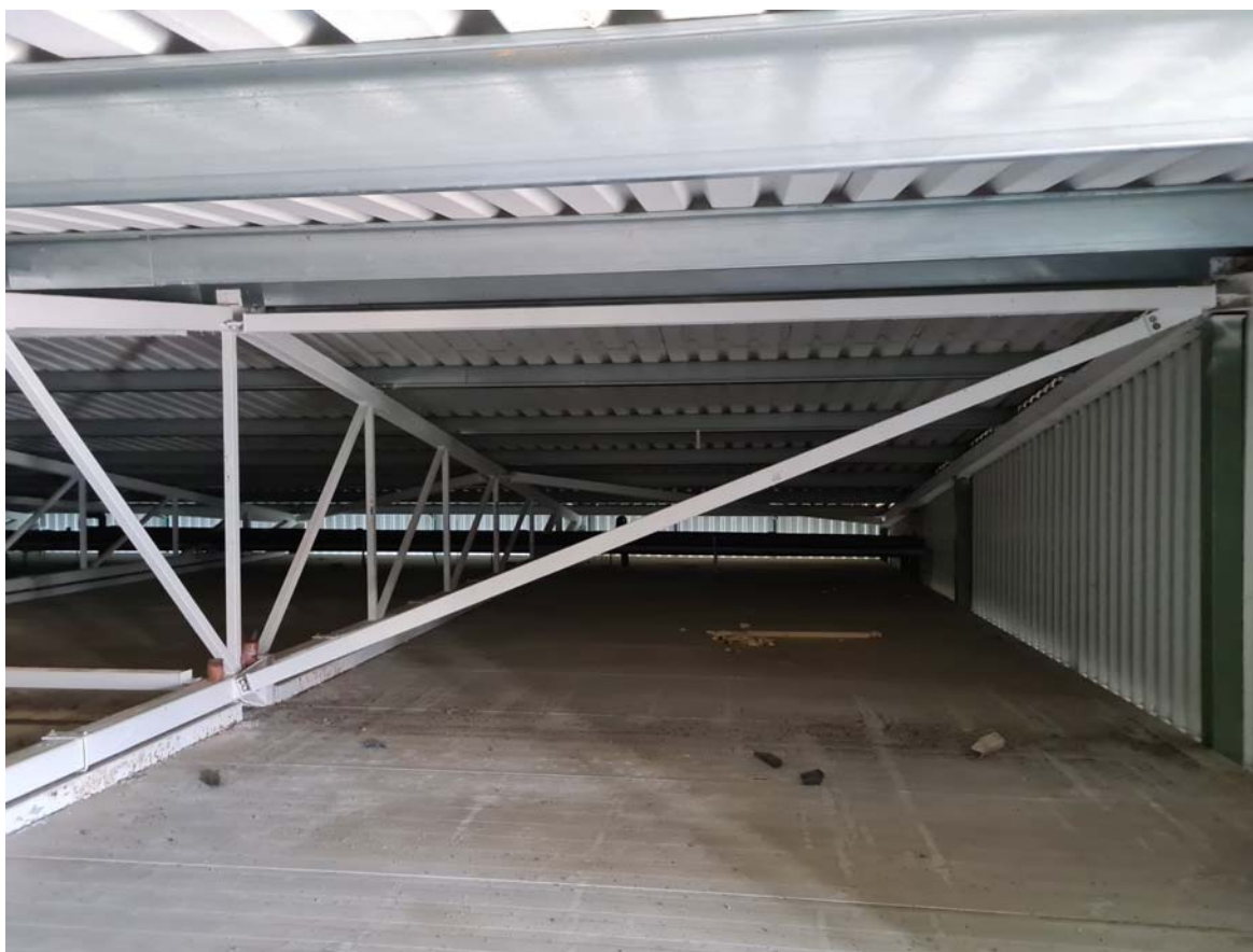
507 pav. Pastato Nr.5 stogo konstrukcijų fotofiksacija ir apmatavimai. Denginio konstrukcijų matmenys atitinka nurodytus archyvineame projekte.
