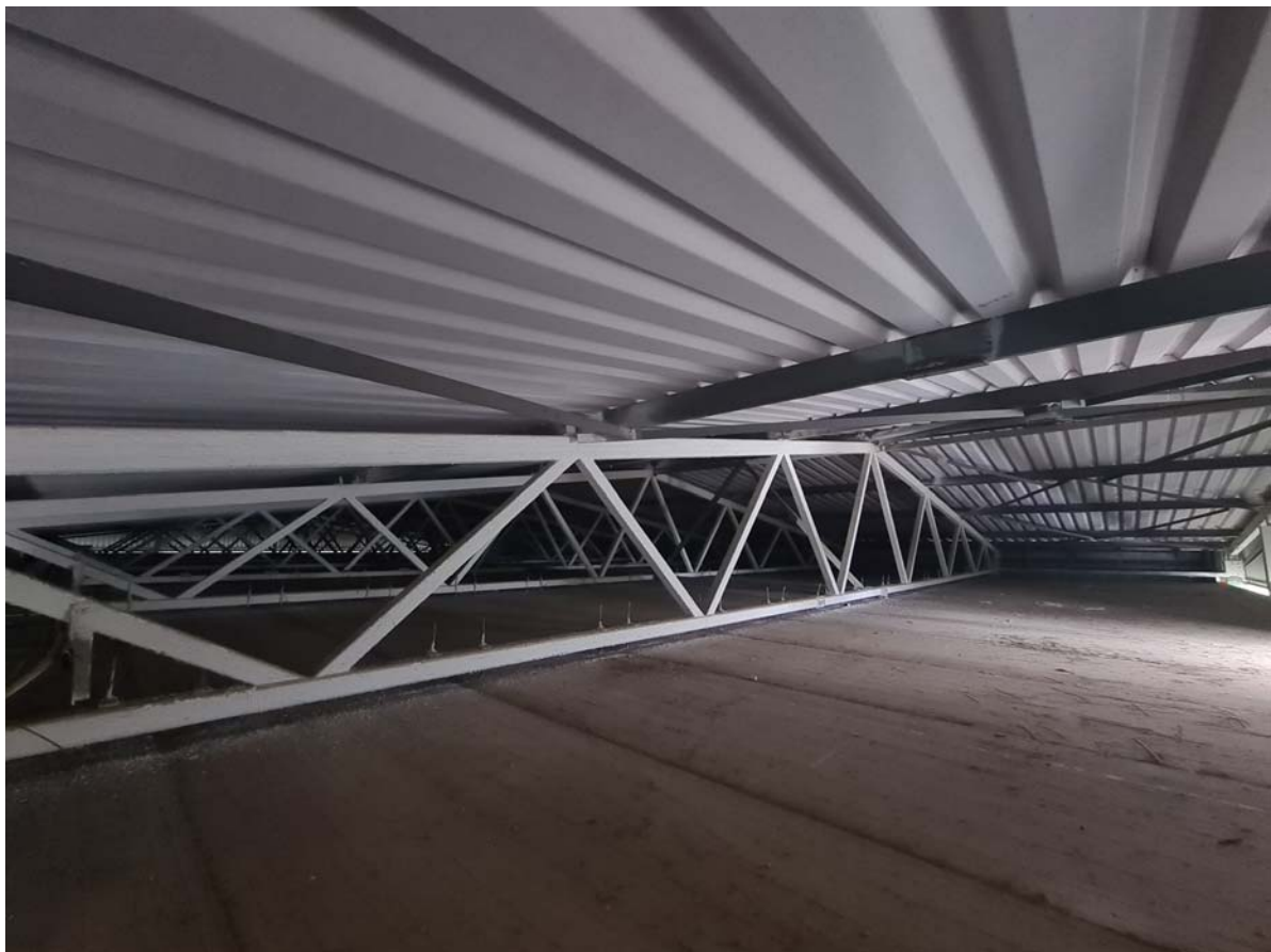
403 pav. Pastato Nr.4 stogo konstrukcijų fotofiksacija ir apmatavimai. Denginio konstrukcijų matmenys atitinka nurodytus archyvineame projekte.
