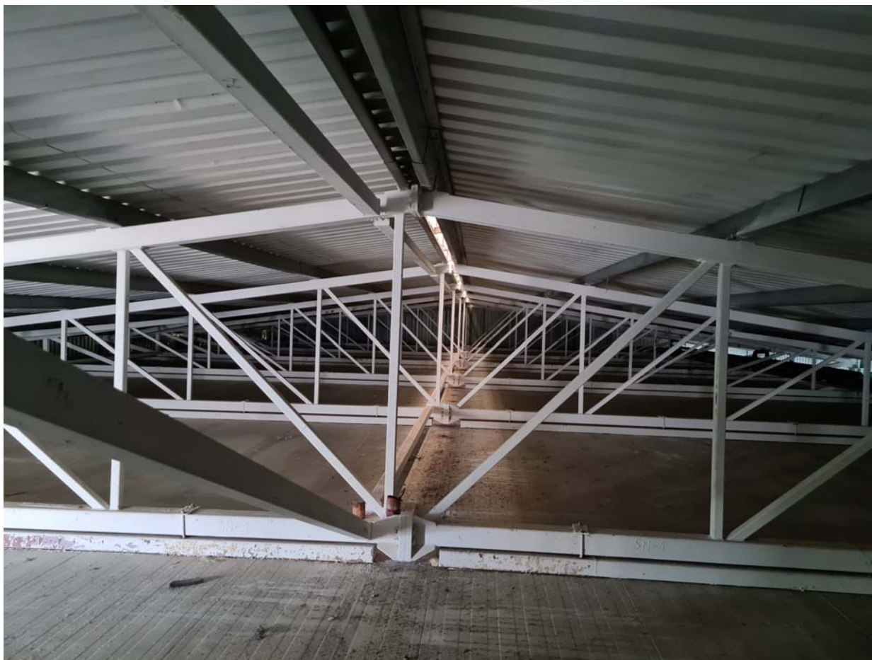
506 pav. Pastato Nr.5 stogo konstrukcijų fotofiksacija ir apmatavimai. Denginio konstrukcijų matmenys atitinka nurodytus archyvineame projekte.
