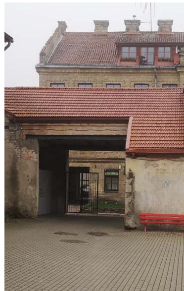
12 pav. pastato Nr. 2.1 lauko fotografacija
