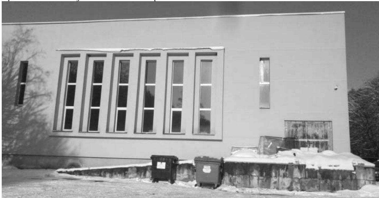
6 pav. Esama situacija. Atvira konteinerių aikštelė
