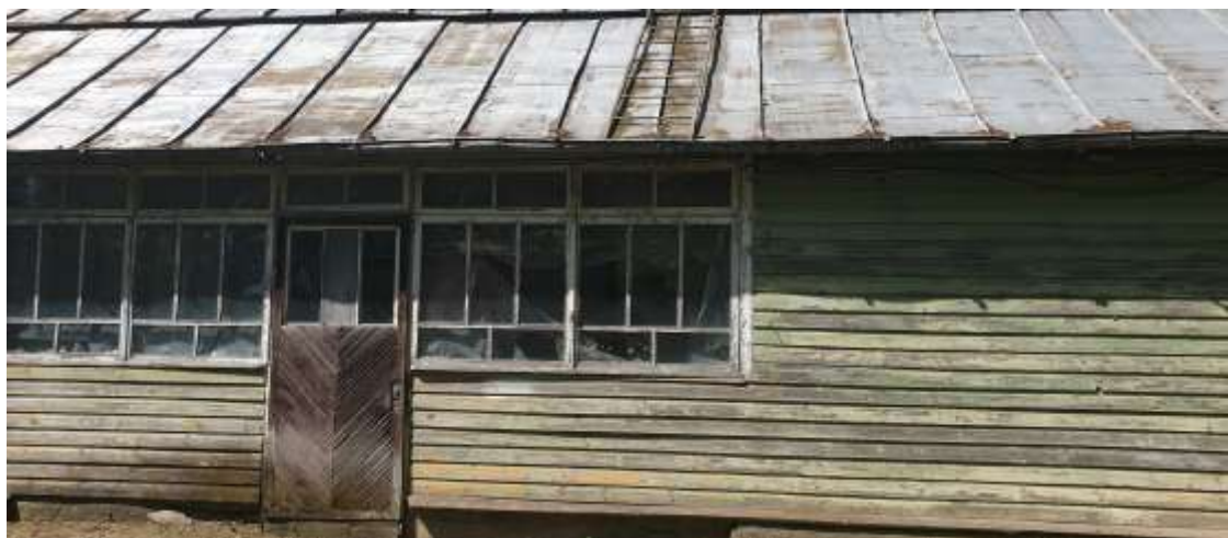
12. pav. Pastato lauko sienos fragmentas, apkaltos vietomis įmirusiomis dailylentėmis, sutrūkęs pamato fragmentas
