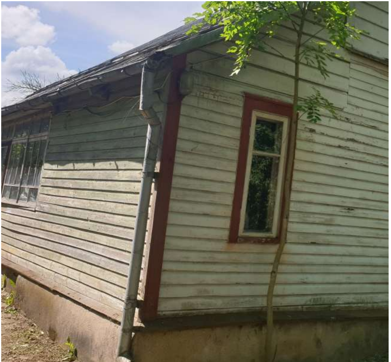
22. pav. Pastato lietaus nuvedimo fragmentas, atmosferinis vanduo nenuvedamas nuo pasato
