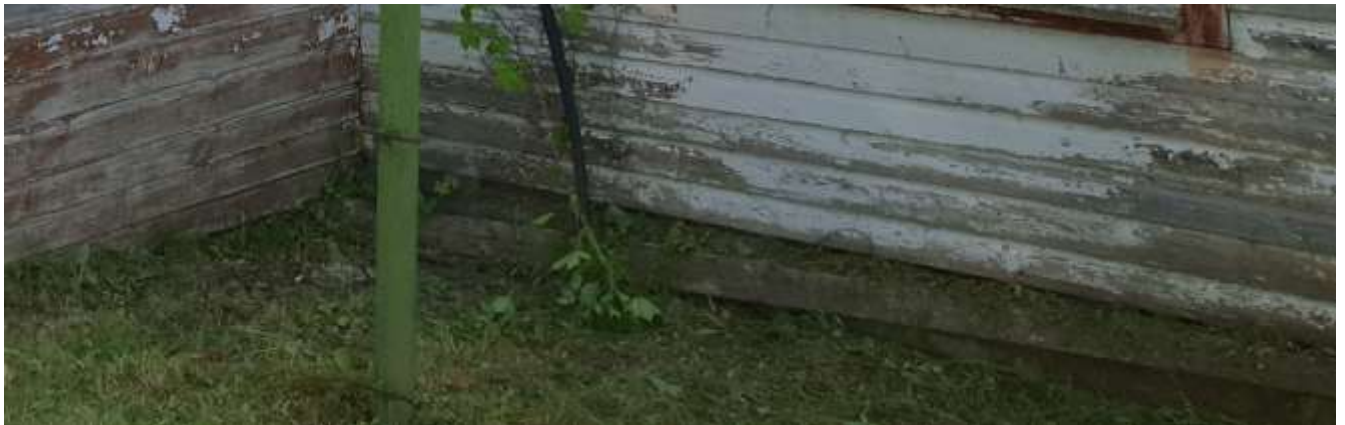
8. pav. Pastato cokolio, nuogrindos fragmentas, pamatas labai žemas, siena beveik liečiasi su gruntu vietomis nėra nuogrindos, įmirkusi išorinė sienų apdaila
