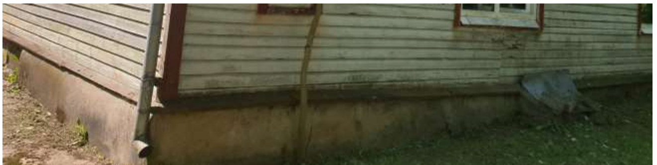
9. pav. Pastato cokolio fragmentas, nėra tinkamos horizontalios hidroizoliacijos, pamatas veikiamas kapiliarinės drėgmės, nėra nuogrindos, ne po visais langais yra palangės
