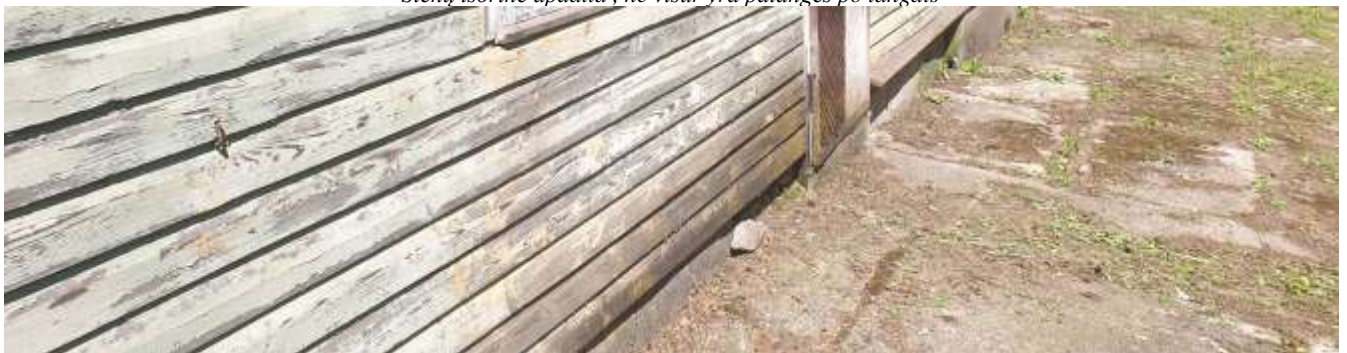
11. pav. Pastato cokolio fragmentas, sutrūkęs pamatas ir siena dėl netolygių nuosėdžių, nuogrindos nėra
