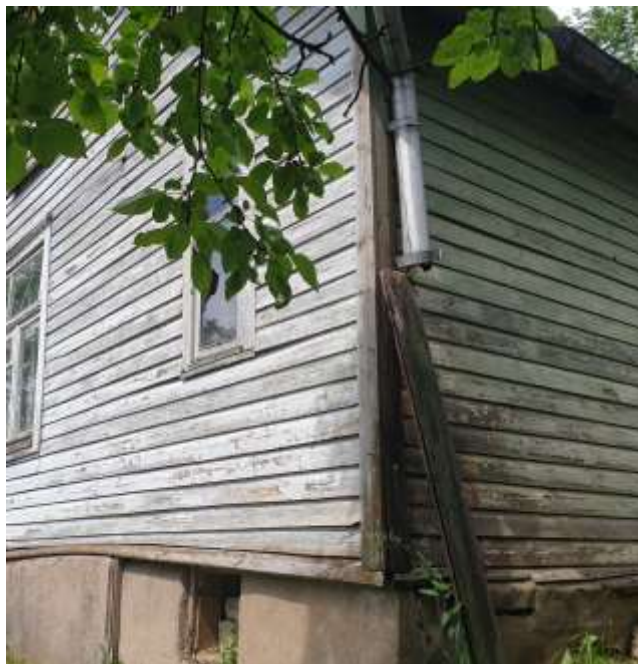
24. pav. Pastato stogo/lietaus nuvedimo fragmentas, ddėl netinkamo lietaus sistemos nuvedimo drėksta sienos
