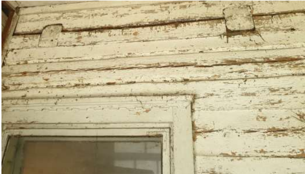
13. pav. Pastato buvusi išorės/ lauko sienos fragmentas su per perdenginio sijų atrėmimo vietomis
