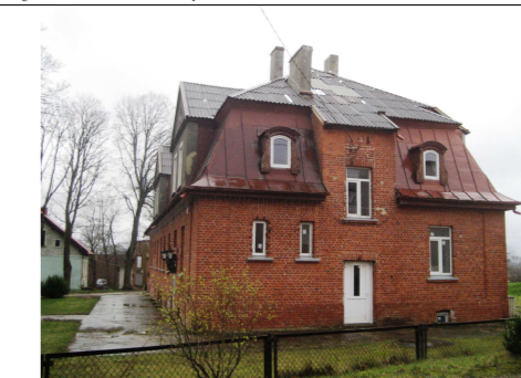
Nr. 4 Pavadinimas Pastato Žalgirio g. 2 vakarų fasadas Fotografo Margarita Ramanauskienė Data 2020-03-07
