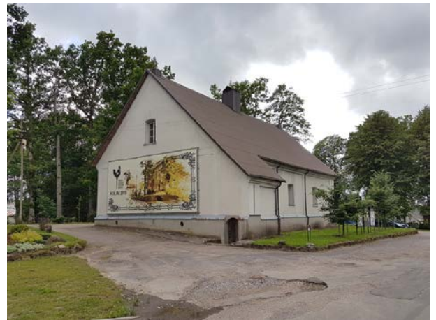
Kulių Šv. vyskupo Stanislovo bažnyčios statinių komplekso Šiaurės pastatas (KVR 28291), 2020
