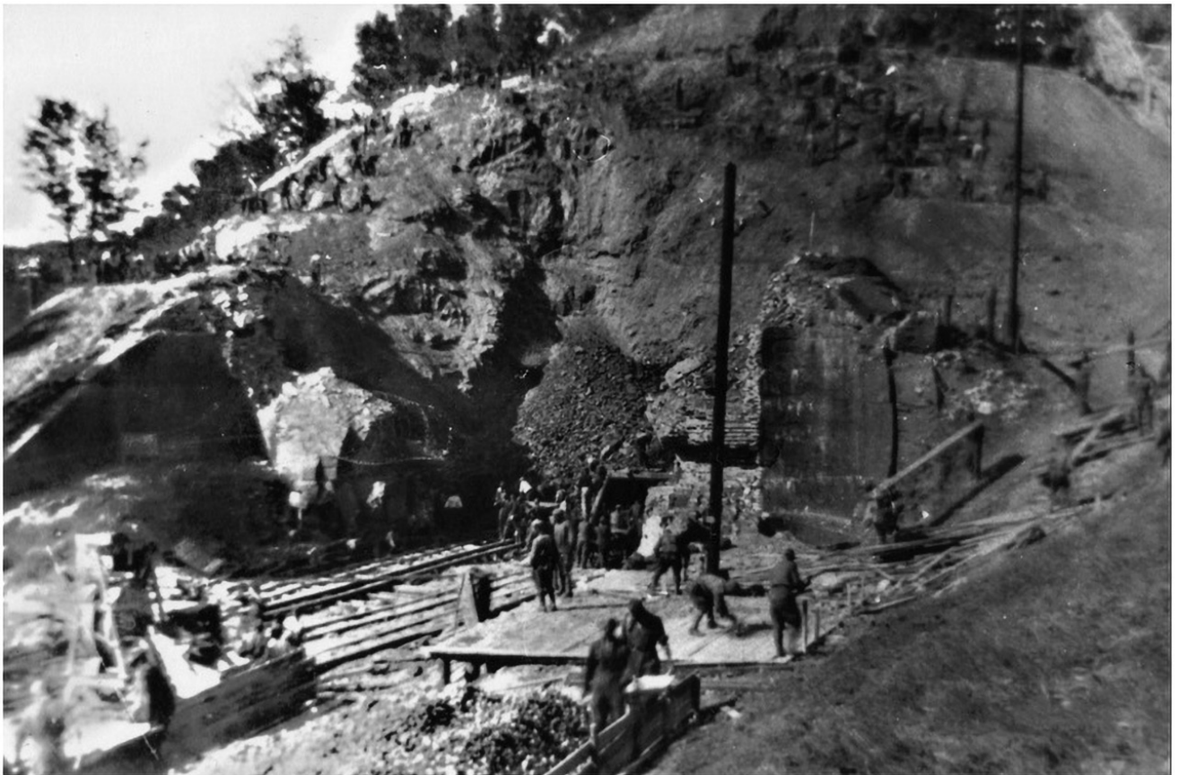
1944 m. tunelio atstatymo darbai
