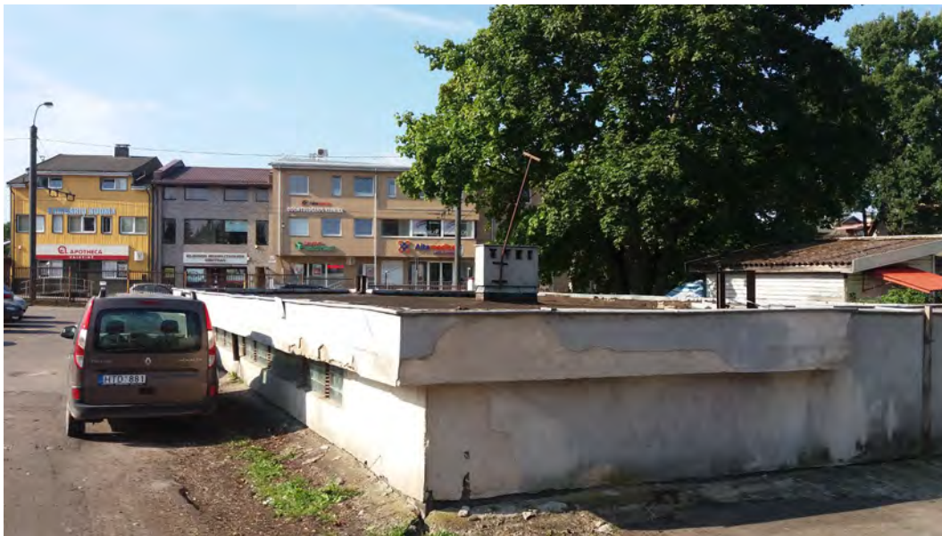
10 pav. Esamas pastatas, vaizdas nuo esamos antžeminės automobilių aikštelės (esama situacija).
